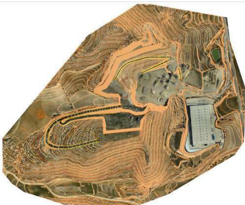
Figura 10. Fase 5: avance parcial del banco a cota 590
