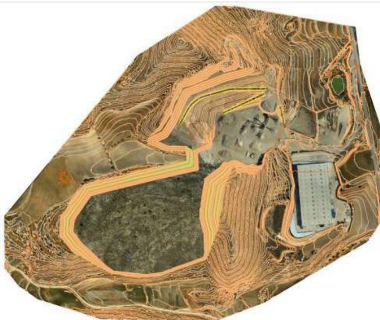
Figura 20. Fase 15: avance completo del banco a cota 550
