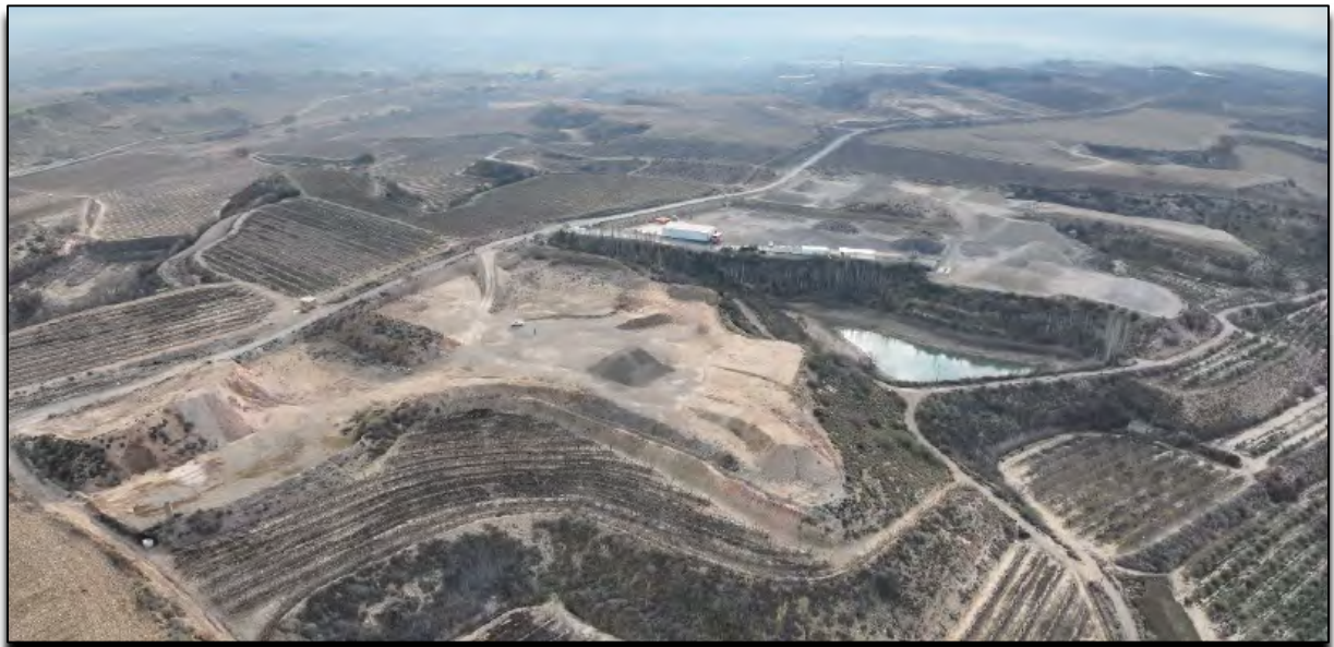
Figura nº 3. Vista aérea de la zona de cantera “TORRE DEL CARMEN II”, en primer término, parcela 172. (Fecha: febrero de 2025).
