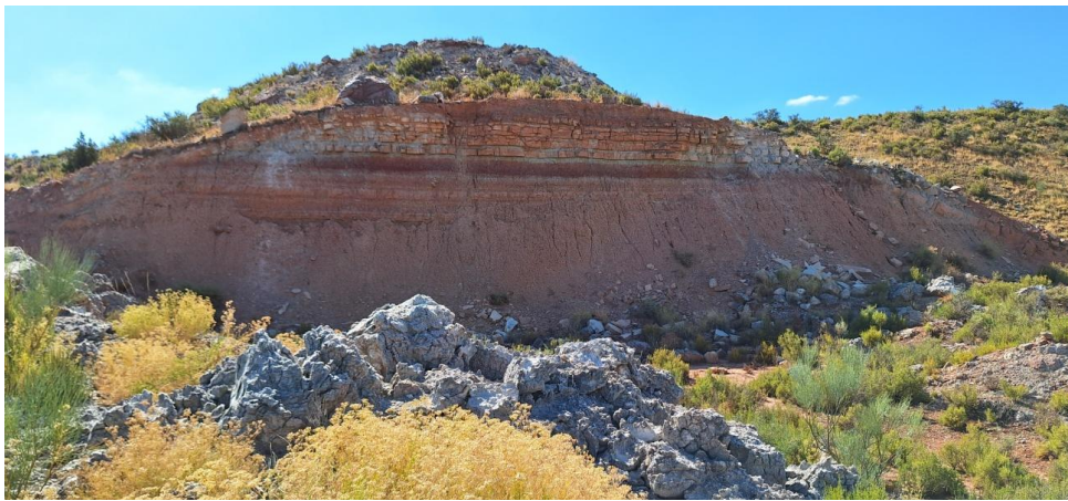
Figura 34. Corte estratigráfico en frente de explotación antiguo en el punto 10. Nivel de plaza entorno a la cota 195 m. y bancos de calizas coronando en frente entorno a la cota 205 m. y superiores.
