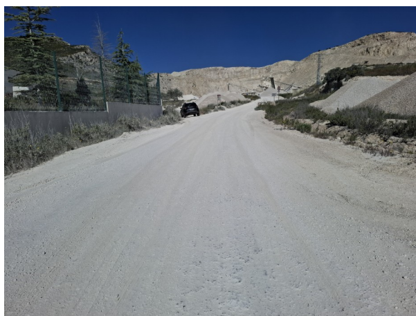
Figura 14. Tramo final de la pista de acceso, sin asfaltar
