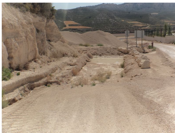
Figura 12. Balsa de decantación excavada a la entrada a la explotación.
