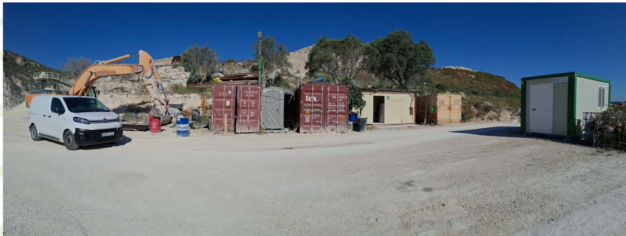
Figura 19. Parque de maquinaria y casetas prefabricadas que se utilizan como almacén, vestuario y aseo.
