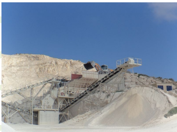
Figura 10. Proceso de carga en la tolva de la planta de tratamiento.
