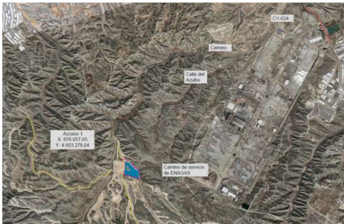
Figura 3: Accesos al Parque Solar FV.
