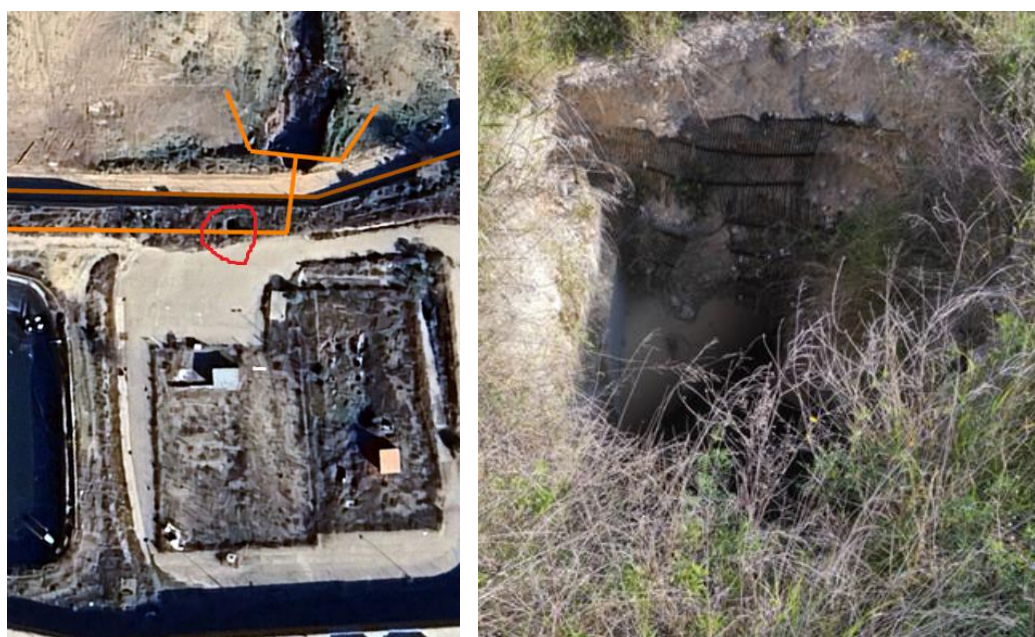
Figura 7. Lavado del material del relleno en las inmediaciones de las redes de pluviales y residuales
