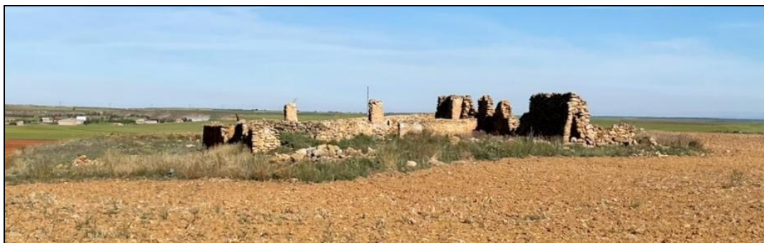
Fotografía 69. Antigua edificación agropecuaria en ruinas.
