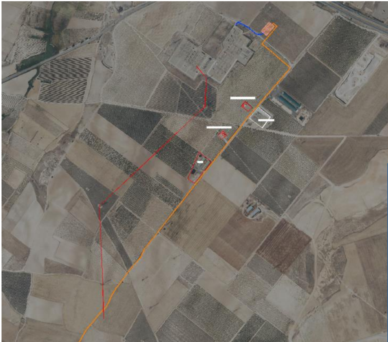
Figura 13: Cruzamiento línea eléctrica 400 kV
