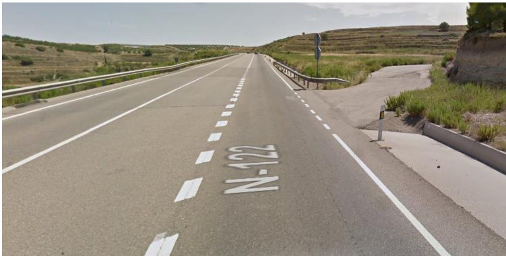
Imagen 2: Acceso desde la N-122 en el T.M. de Tarazona.
