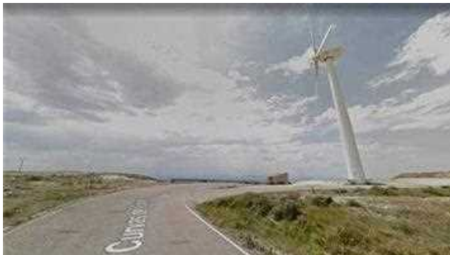
Foto del segundo acceso al Parque Eólico "La Muela II Modificación"
