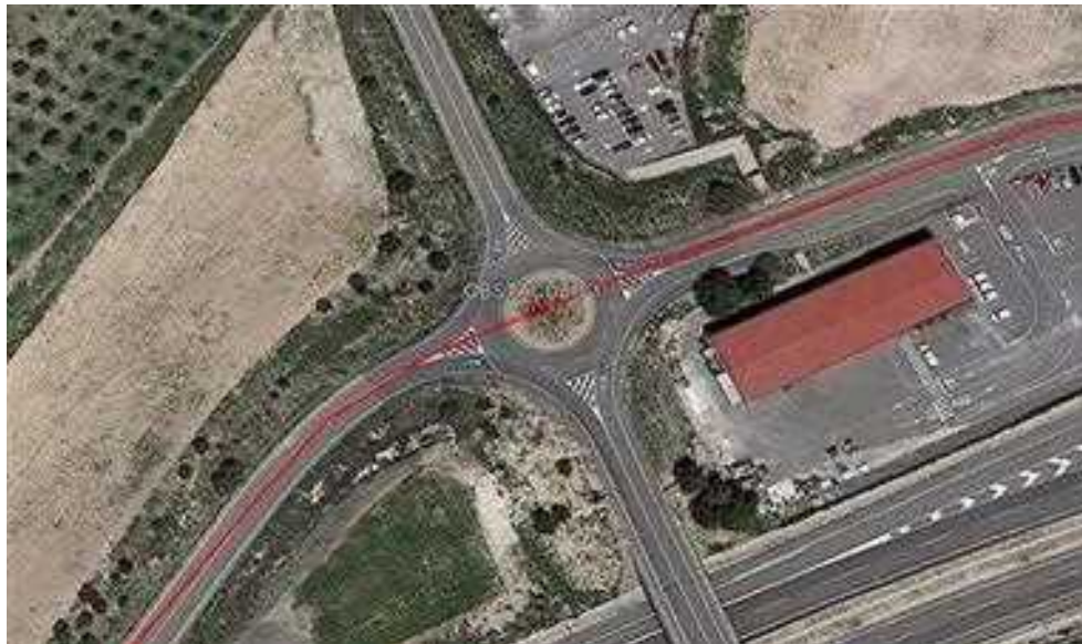
Ruta 1. Rotonda a desmontar (Fuente: Google Earth)
