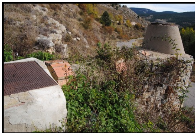
Imagen 3: Arqueta de derivación y pozo P3.
