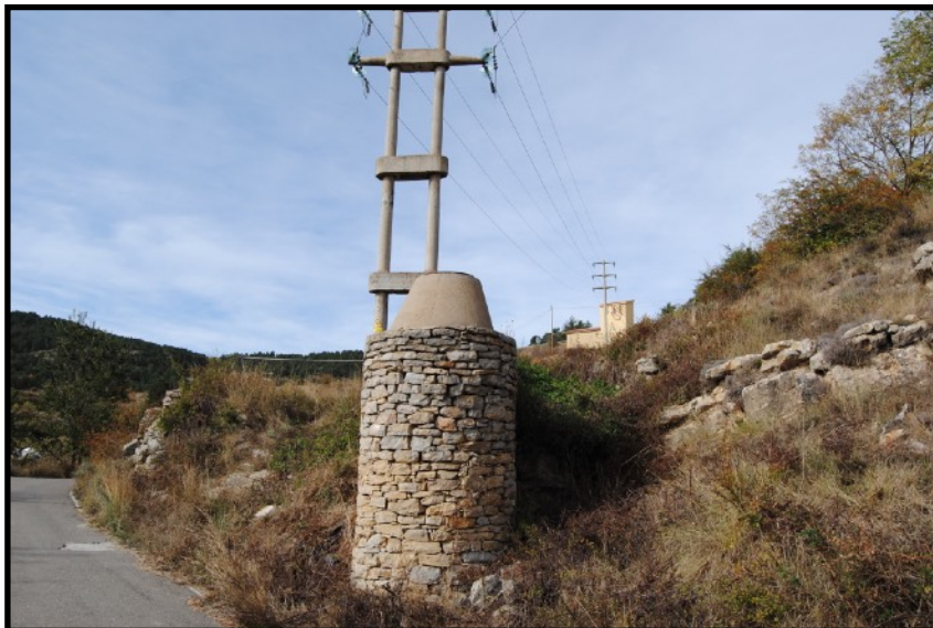
Imagen 5: Pozo P3 existente.
