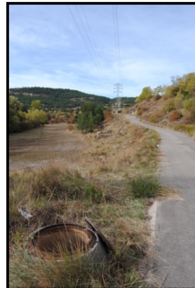
Imagen 6: Pozo P4 existente.
