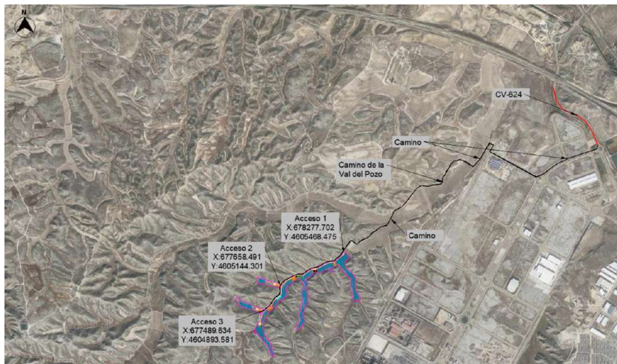
Figura 3: Accesos al Parque Solar FV.
