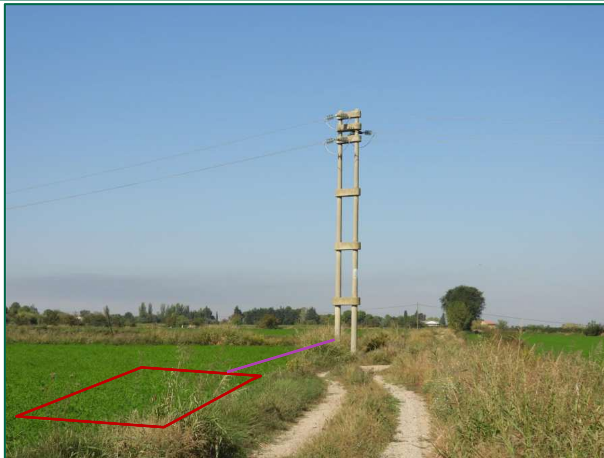
Fotografía 14. Llegada de la infraestructura soterrada de evacuación hasta el centro de seccionamiento y circuito subterráneo de media tensión (15 kV) que une la Power Station con el Centro de Seccionamiento de la línea de MT ESTE_C2 perteneciente a la SET PLAZA.
