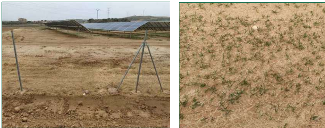
Fotografía 9. Hidrosiembra realizada en el interior del vallado y vista del resultado del crecimiento en su primera etapa. Fuente: restauración para un proyecto propio
