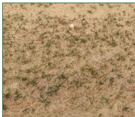
Fotografía 15. Hidrosiembra realizada en el interior del vallado y vista del resultado del crecimiento en su primera etapa. Fuente: restauración para un proyecto propio
