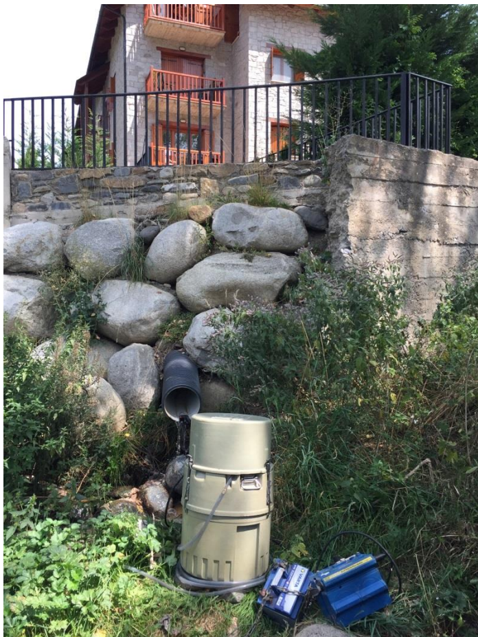
B3 Vertido Apartamentos Anciles – Antes cuartel Guardia Civil
