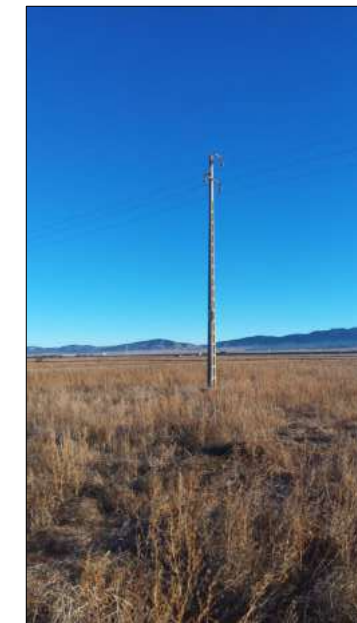
Apoyo 20 existente a sustituir
