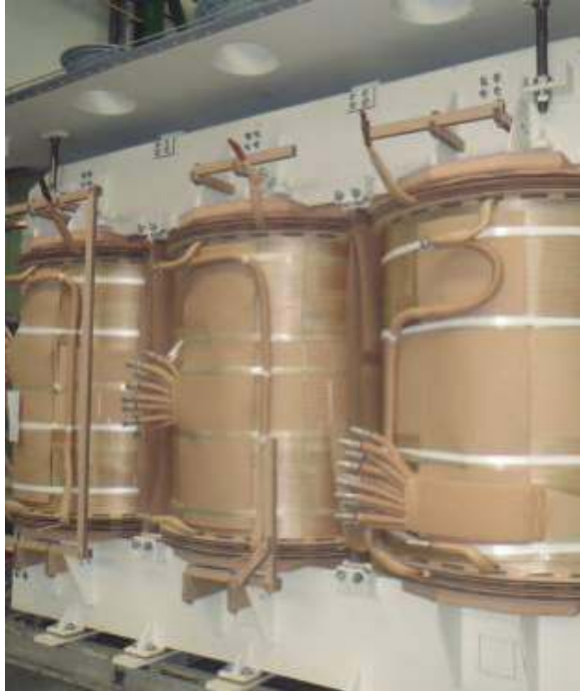
Parte activa del transformador
