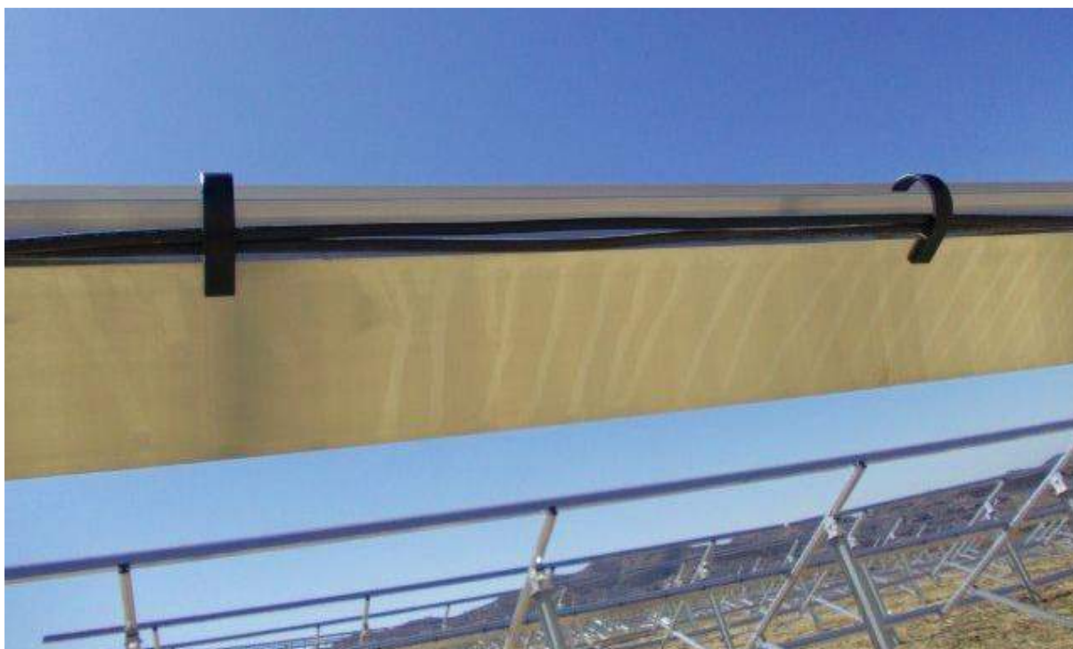
Imagen 6: Ejemplo de fijación del cable solar a la estructura.
