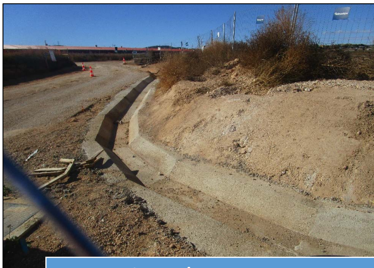
Camino de acceso y cuneta
