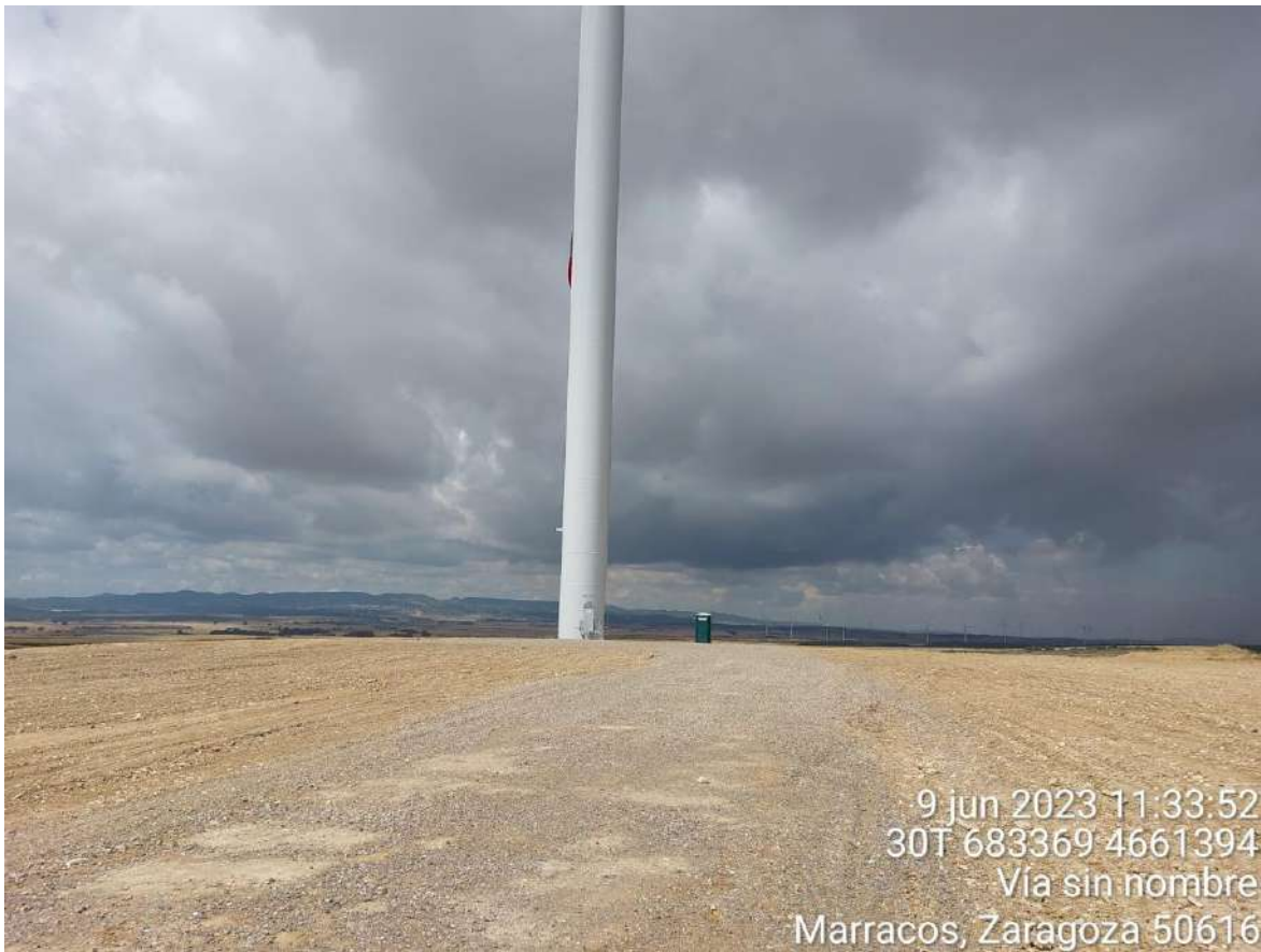
Imagen 2. Posición OBIII-01 tras realizar los trabajos de restauración morfológica.
