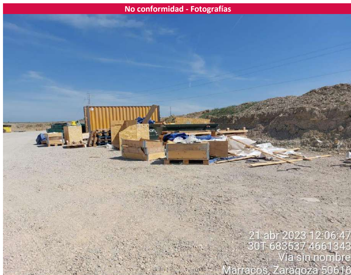
Imagen 1. Punto limpio de NORDEX. Se debe ordenar y recoger. Se comprometen a hacerlo inmediatamente.
