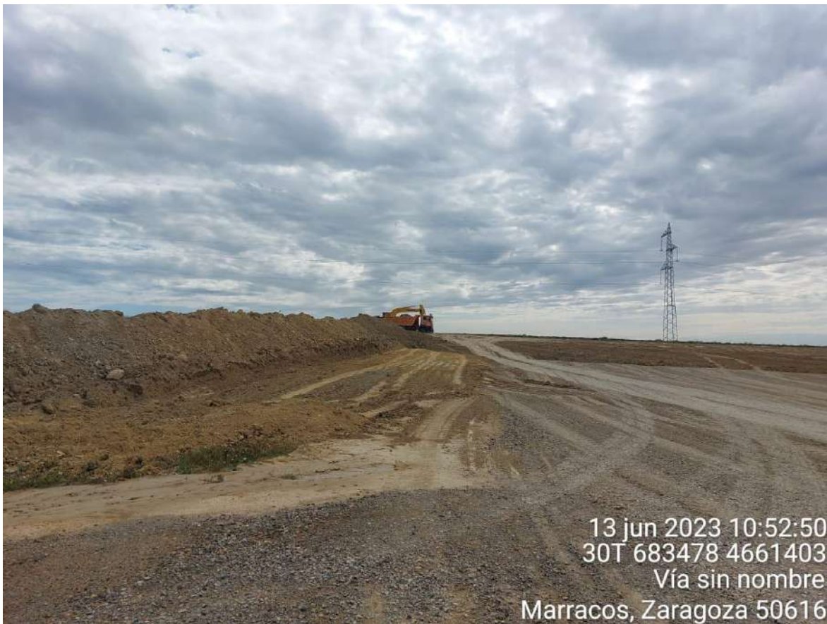
Imagen 3. Trabajos de restauración en la campa de acopio de OBIII.
