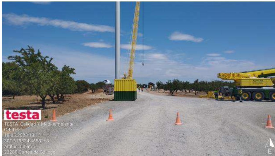
Trabajos en OB2-3
