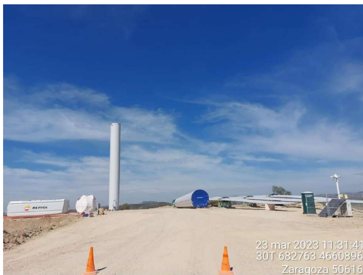
Imagen 1. Posición OBIII-02 con el material acopiado en plataforma.
