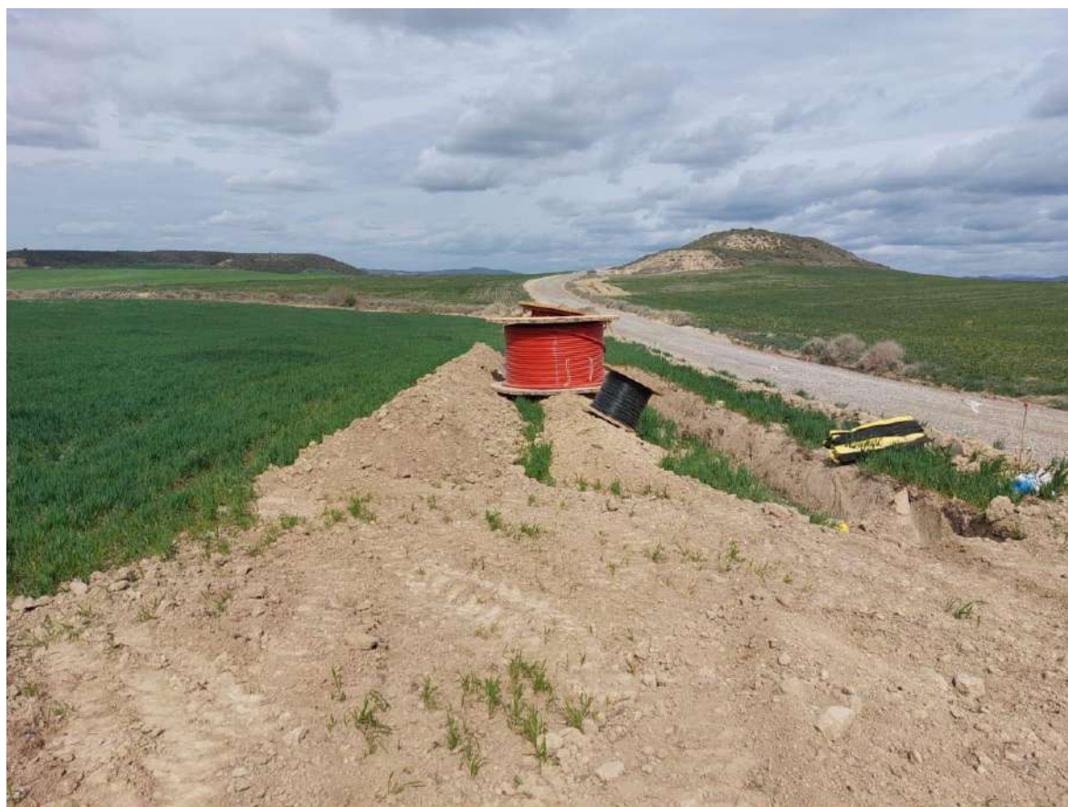
Imagen 1. Zanja de evacuación OBIII.
