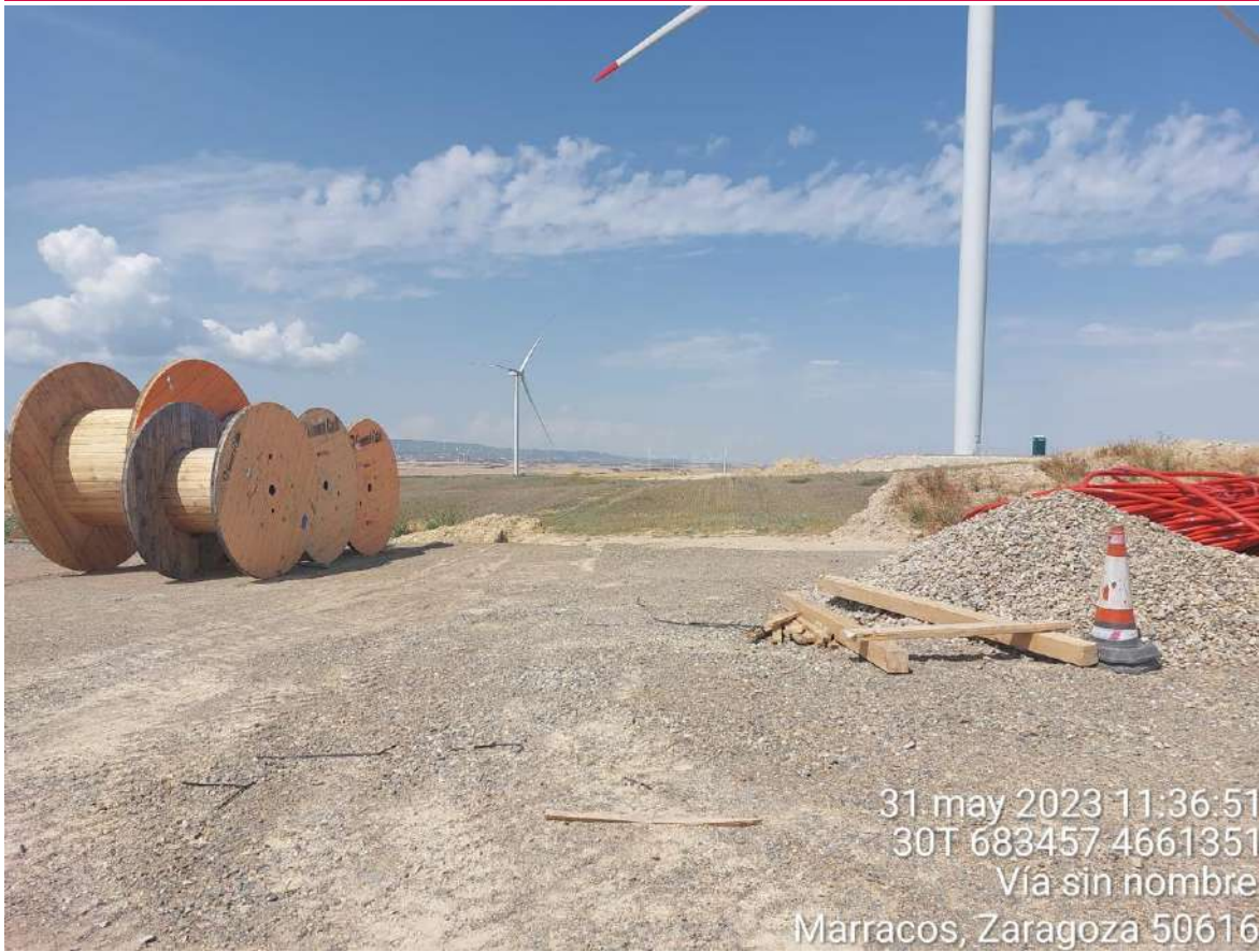
Imagen 1. Bridas y demás residuos en la campa de acopio y el punto limpio de Collosa.
