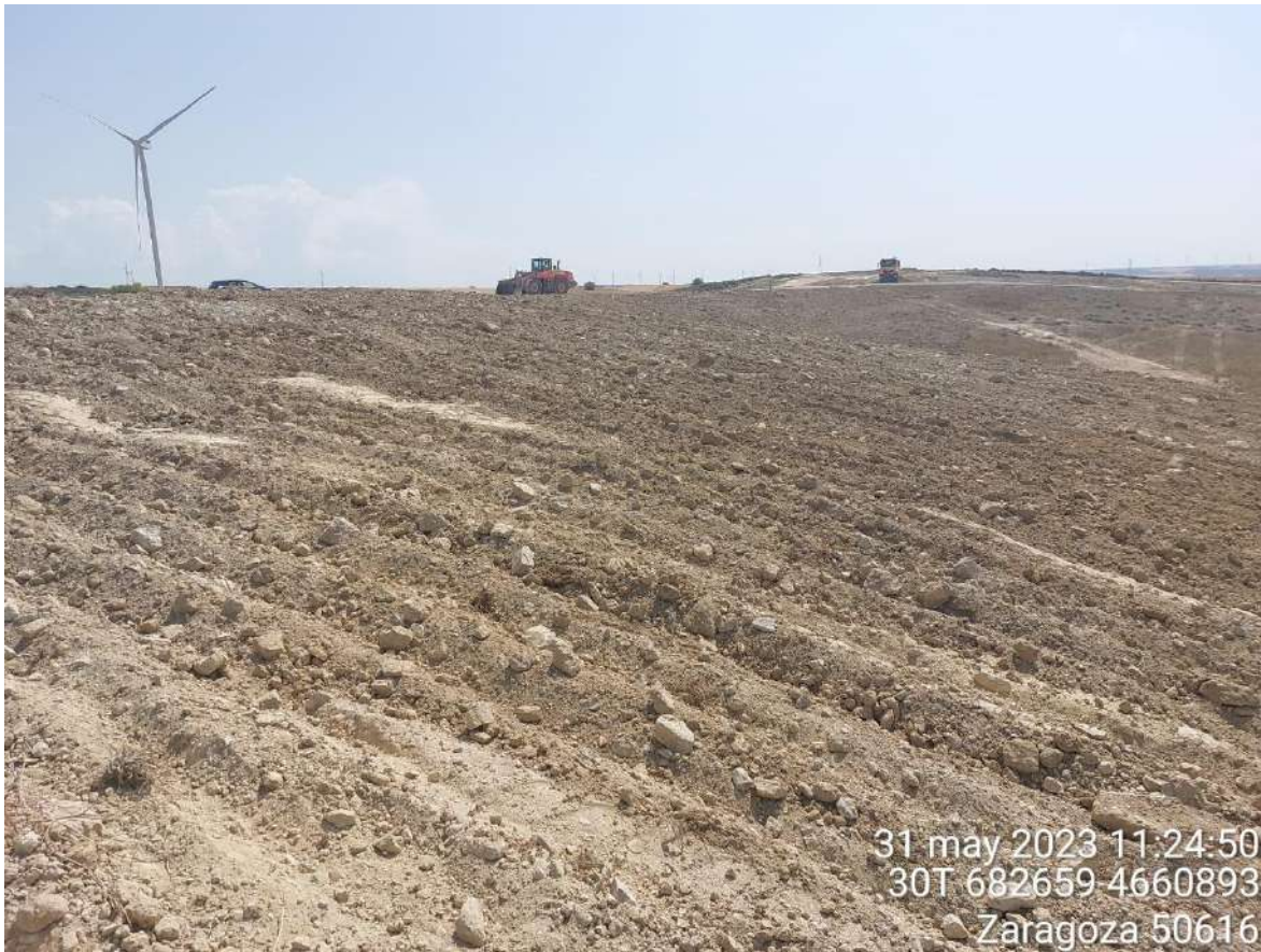
Imagen 3. Restauración morfológica de OBIII-02 todavía sin terminar.
