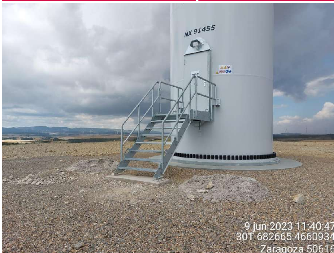
Imagen 1. Observación realizada en OBIII-02 debido a residuo de hormigón tras trabajos en la escalera.
