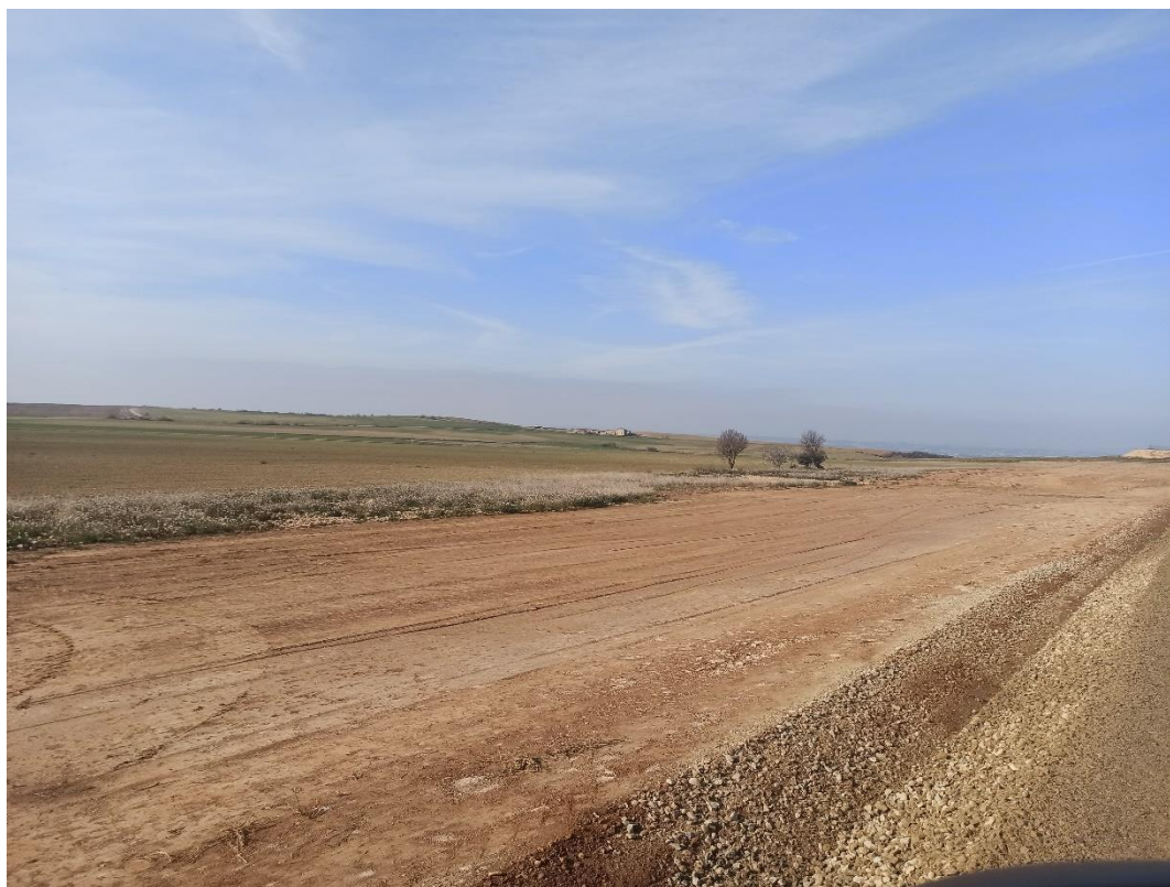
Fig. 1 Zona de tierra vegetal compactada
