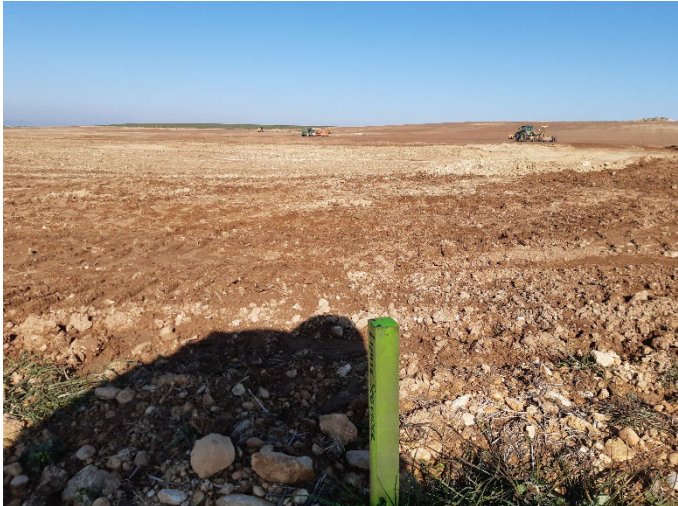
Fig. 3 Detalle de los trabajos de seguidores solares con límites definidos
