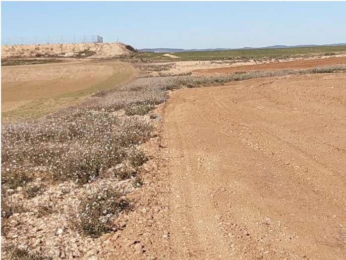
Fig. 2 Estaquillado en zona sur del vallado perimetral
