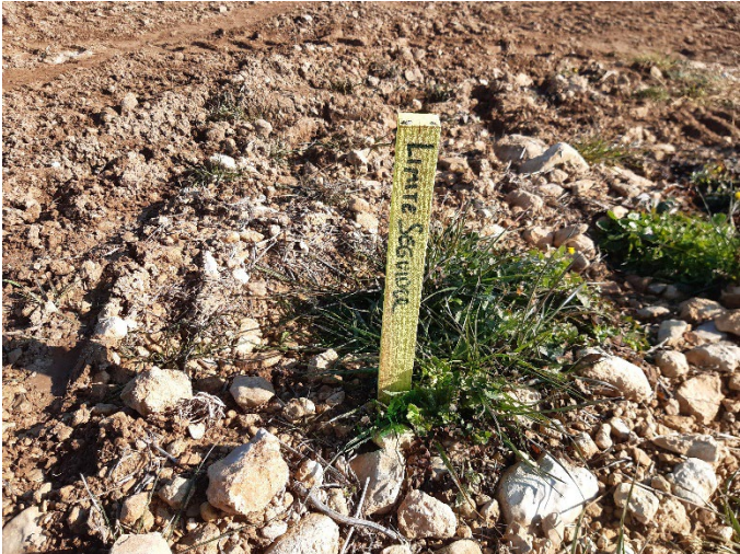
Fig. 2 Detalle de estaca empleada para marcar el límite de seguidores
