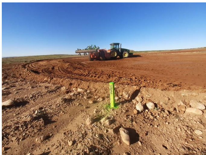
Fig. 2 Zona de extendido, con trailla repartiendo tierra vegetal
