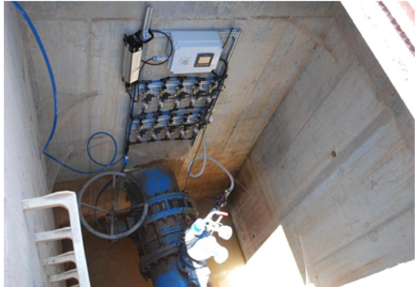
a) Instalación y programación de un transductor de presión en uno de los hidrantes de la red 1 de la CCRR de Collaradas 1ª Sección de Montesusín (b). Puntos de instalación del muestreador larvario en un punto de la red que da inicio a la zona con mayores problemas de mejillón cebra
