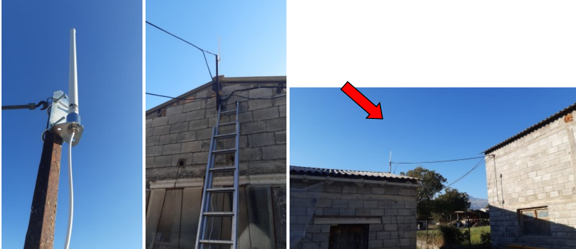
Segunda instalación de la antena en zona más abierta
