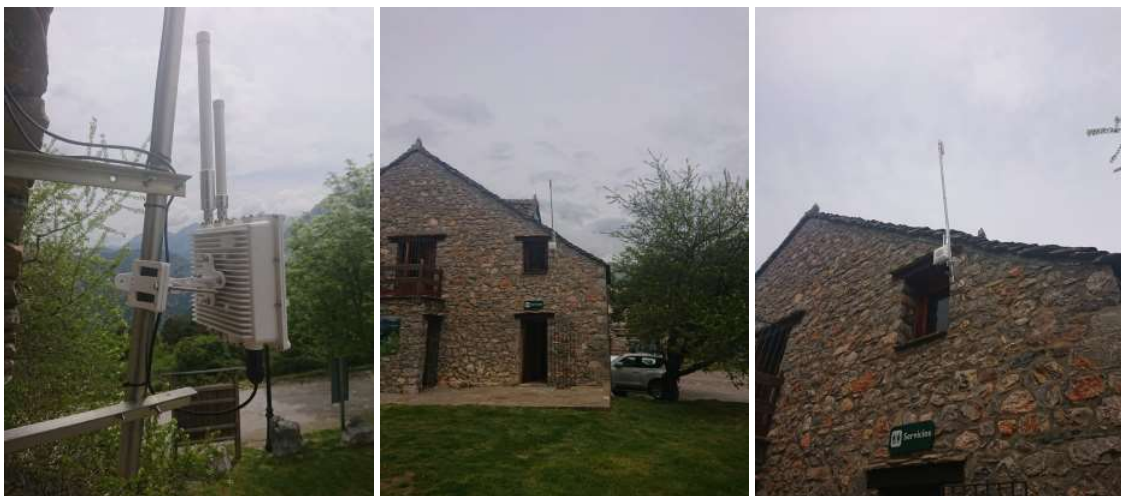
Instalación de segunda antena
