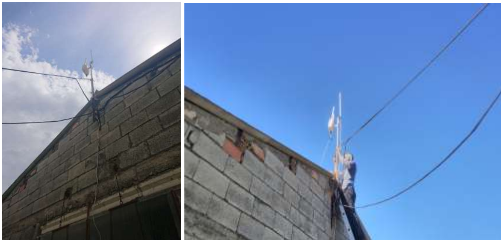
Sustitución de antena por nuevo modelo
