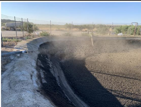
Foto 5. Descarga de arlita como método de cubrición de balsas
