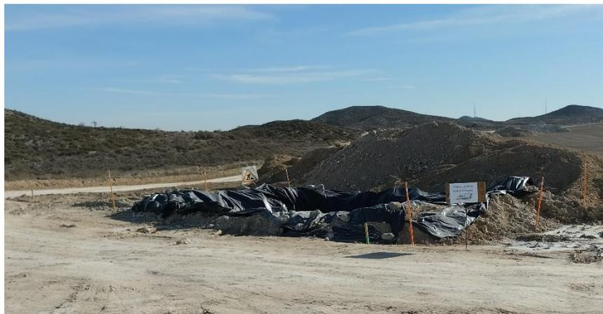
Dispositivo para la limpieza de canaletas de las cubas de hormigón, junto al vial de acceso al aerogenerador ACS 03 (12-01-23).
