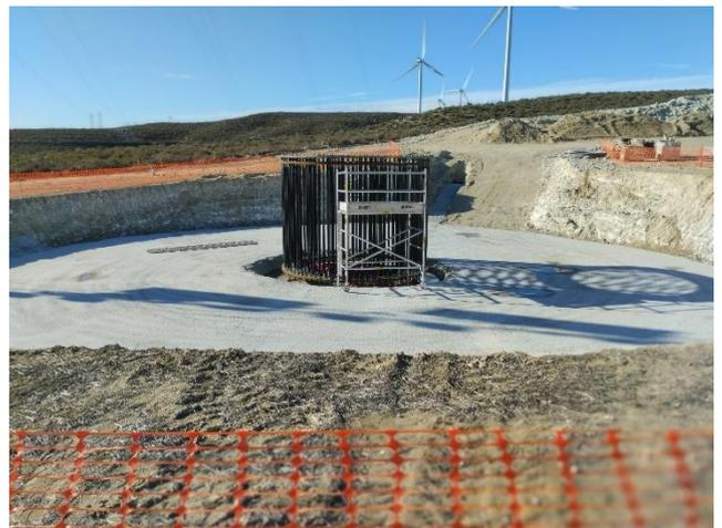
Inicio del montaje de la jaula de pernos en el aerogenerador ACS 03 (izda.), y ACS 04 (dcha.), el 19-01-23.
