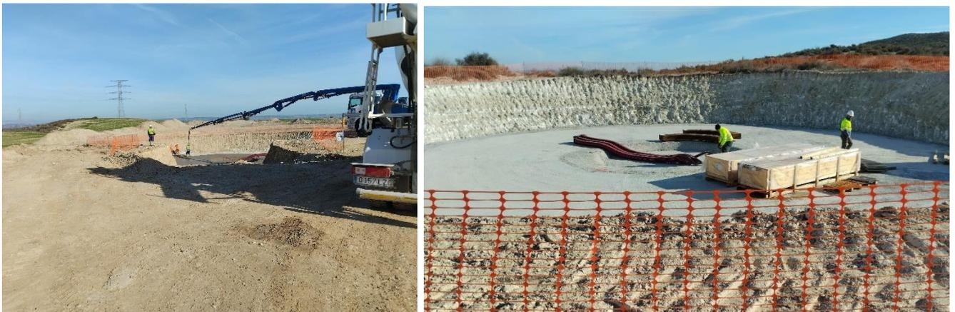
Izda., aplicando hormigón de limpieza en el ACS 02. Dcha., acopiando material para armar la jaula de pernos en el ACS 03 (12-01-23).
