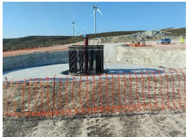
Lento avance del montaje de las jaulas de pernos. Izda., ACS 03. Dcha., ACS 04, (26-01-23).
