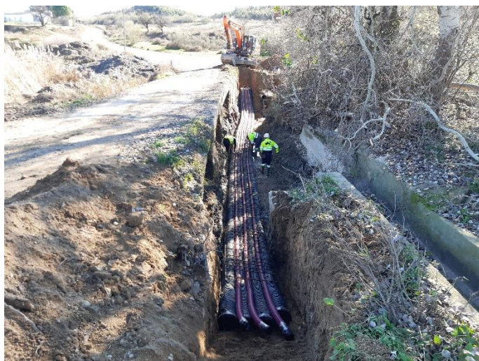
Fig. 2 Colocación de cable de cobre con tubo corrugado y malla para el hormigonado final
