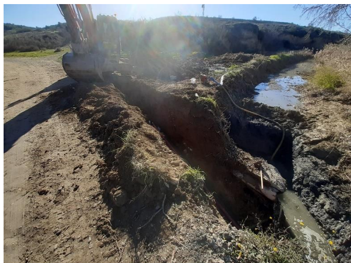
Fig. 1 Apertura de zanja con bomba para extracción de lodos de fondo
