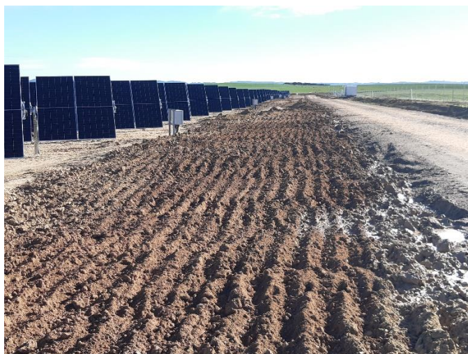
Fig. 2 Tierra vegetal extendida y descompactada
