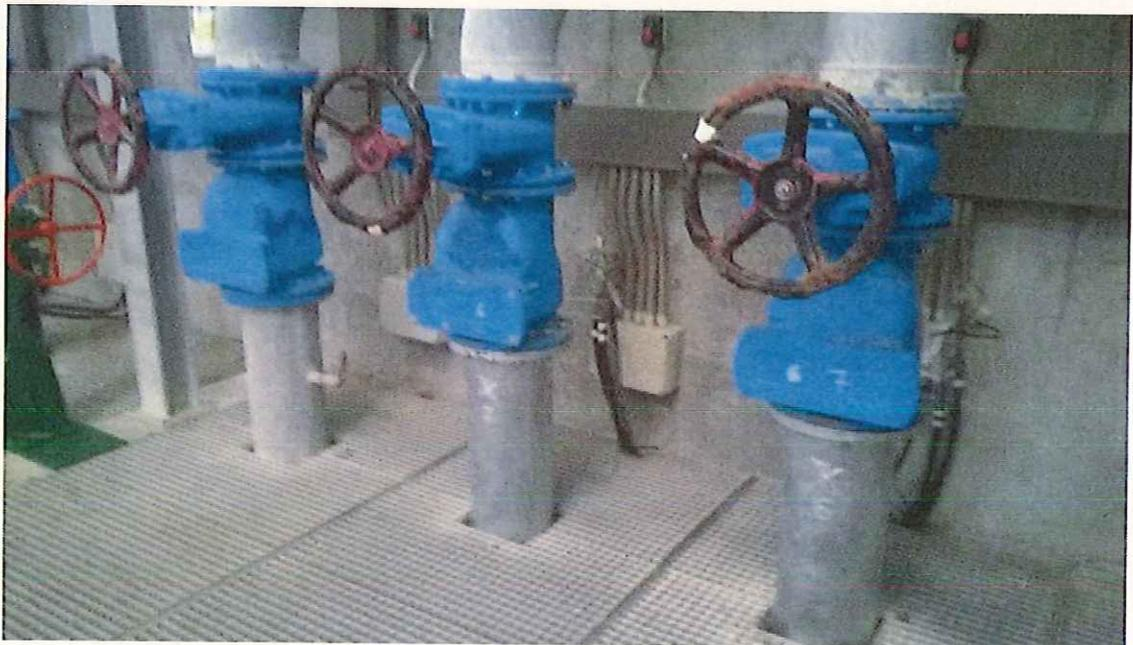
Válvulas de compuerta y antiretorno de los subcolectores 5,6 y 7.
