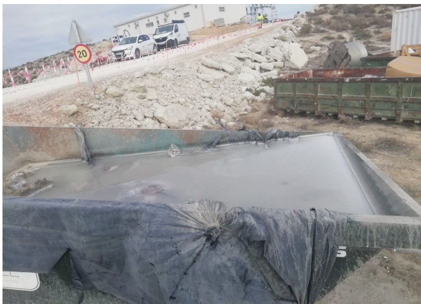
Figura 1: Contenedor de hormigón rebosando.
