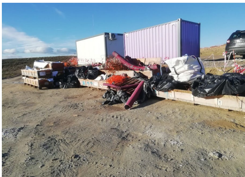
Figura 2: Acopio de residuos fuera de contenedor sin segregar (Pto limpio parque).
