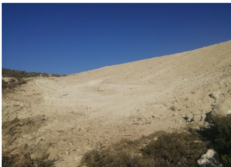
Figura 2: Extendido de tierra procedente de fondo de excavación en posición 01.
