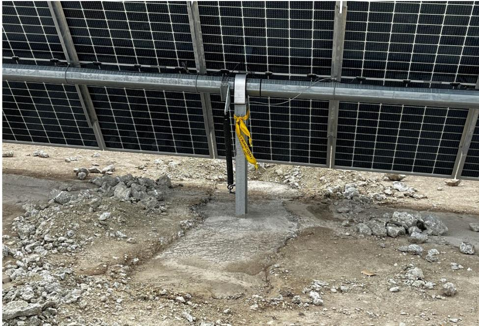
*Figura 39 Cimentación de las hincas rechazadas*
