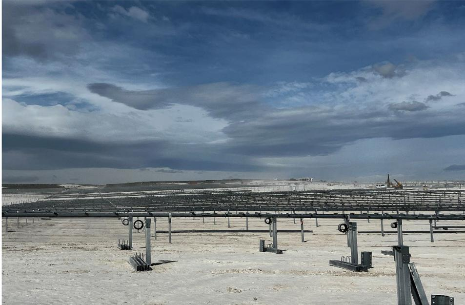
*Figura 37 Montaje de los trackers*
