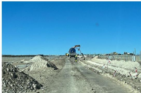
*Figura 10 Tendido de cable de media tensión*
