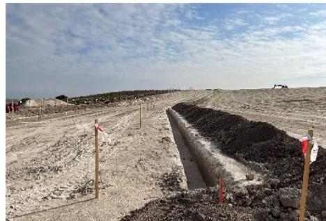
*Figura 3 Apertura de zanjas*
