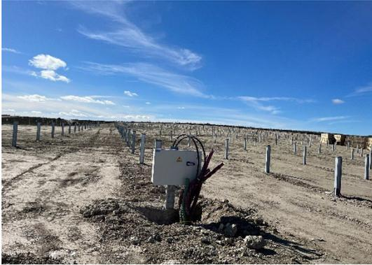
*Figura 11 Montaje de los cuadros de control*
