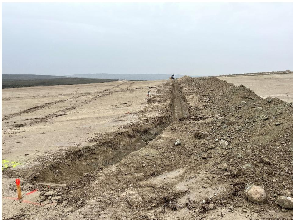
*Figura 9 Apertura de zanjas*
