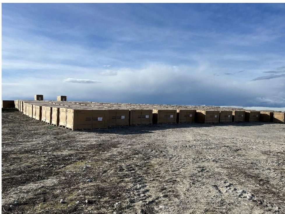
*Figura 10 Acopio de los módulos fotovoltaicos*
