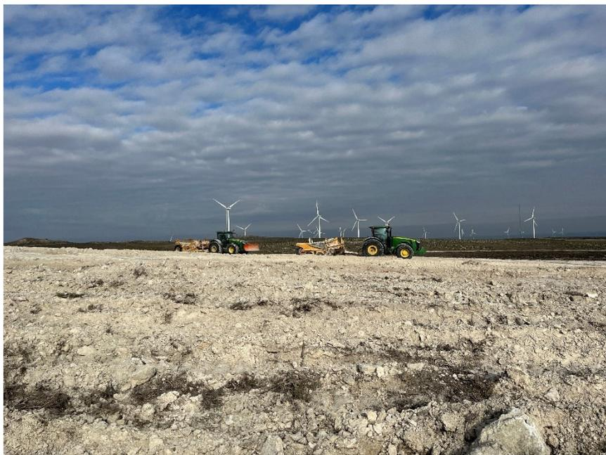
*Figura 2 Trabajos de movimiento de tierras y nivelaciones del terreno*
