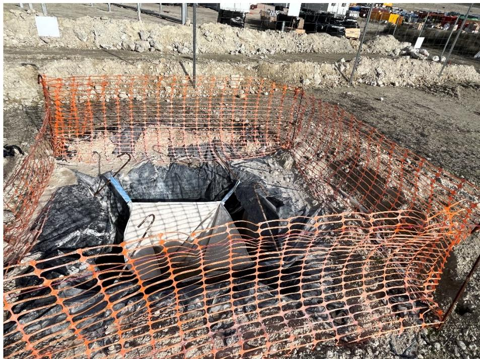
*Figura 11 Lavadero de cubas de hormigón*
