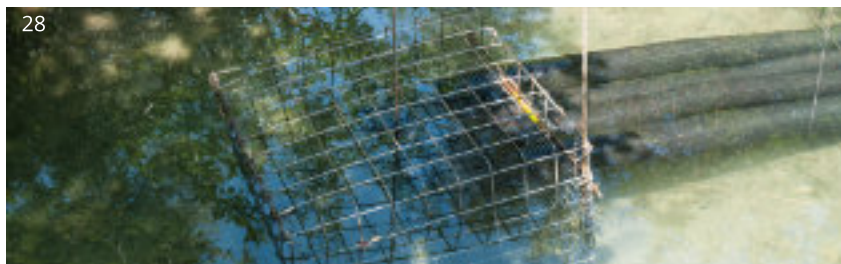
Detalle de jaula para evitar que el castor tapone los tubos.
