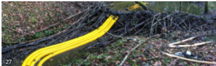
Drenaje de presa mediante tubos plásticos.
