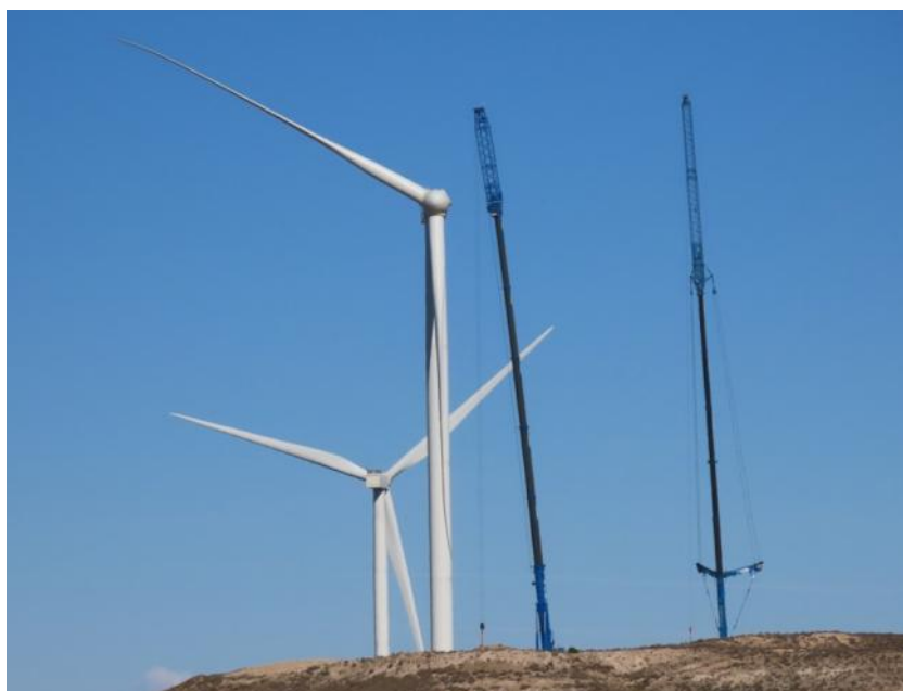
Figura 27: Operación de mantenimiento en MU-9, 13 de abril de 2023.
