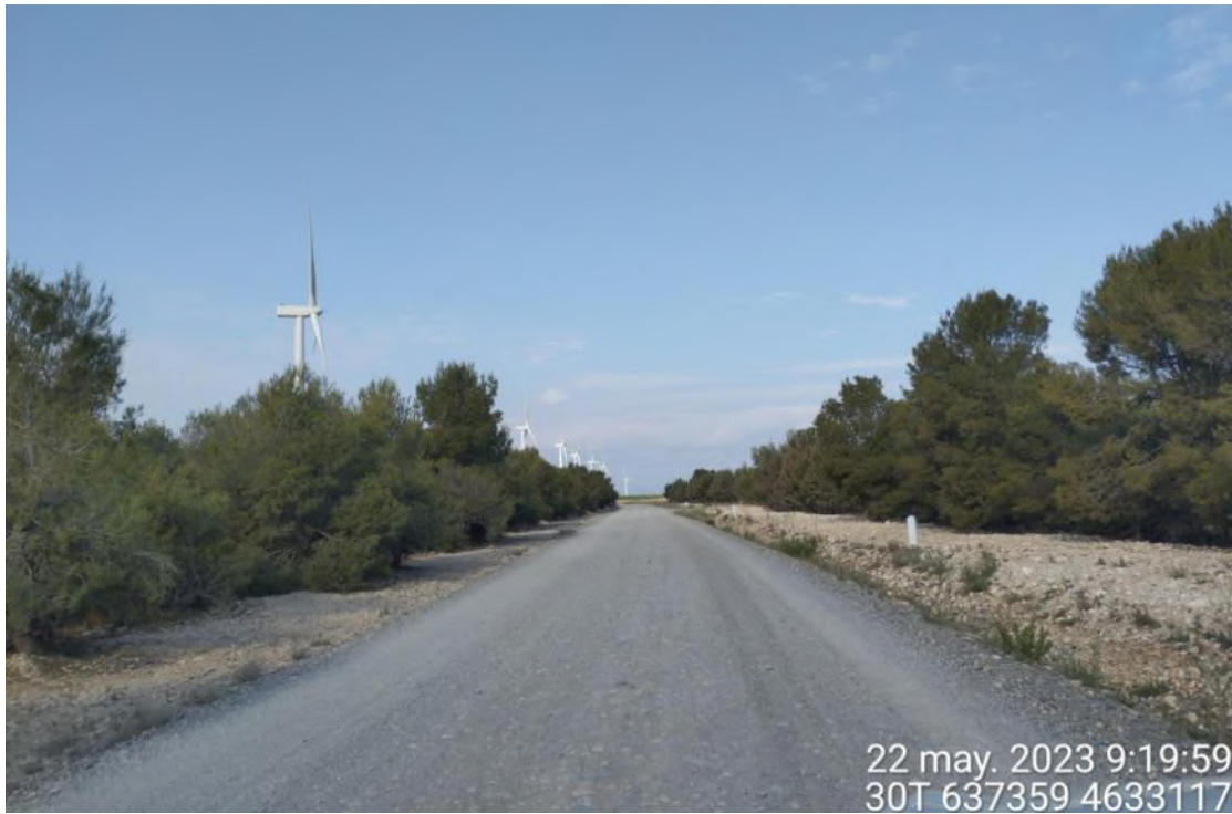
Figura 21: Vial de acceso a la altura de aerogenerador MU-08, cruzando pinar de repoblación.
