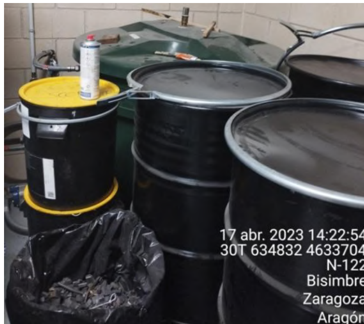
Figura 29: Interior del almacén de residuos de la SET “Valcardera”, con los diferentes residuos peligrosos clasificados con su código LER correspondiente, aislados de la intemperie y sobre una tarima aislante para evitar posibles filtraciones al suelo.
