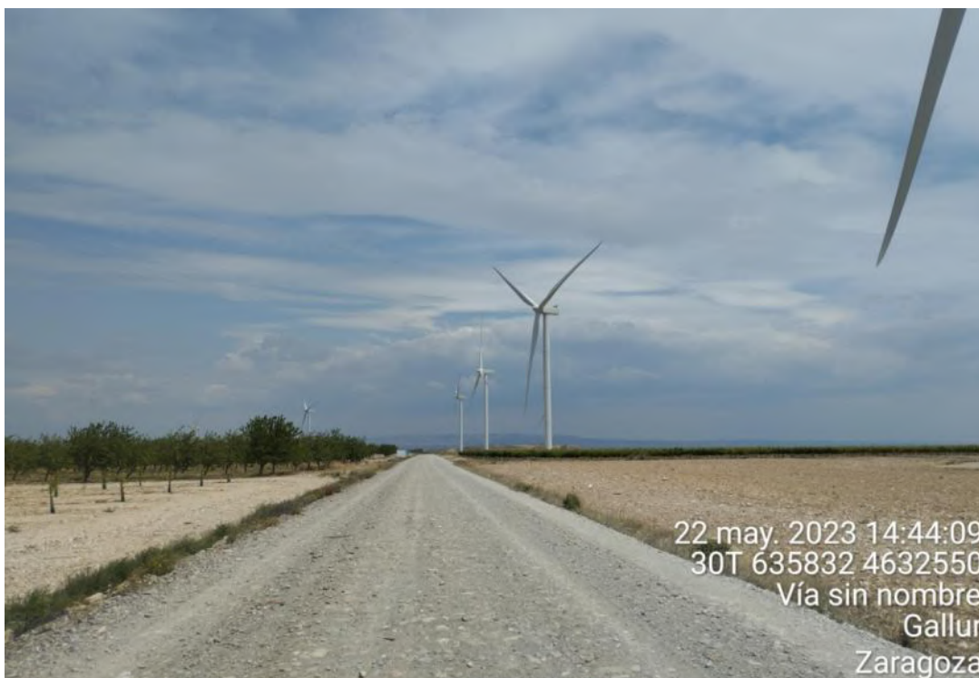
Figura 23: Vial de acceso a la altura de aerogeneradores MU-06 y MU-05.
