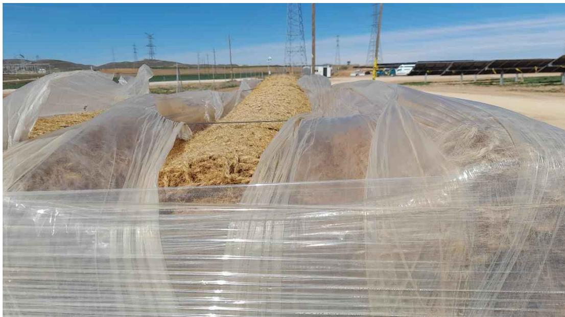
*Foto 15. Acopio de manta orgánica para la revegetación del jarillón de la obra de drenaje.*
