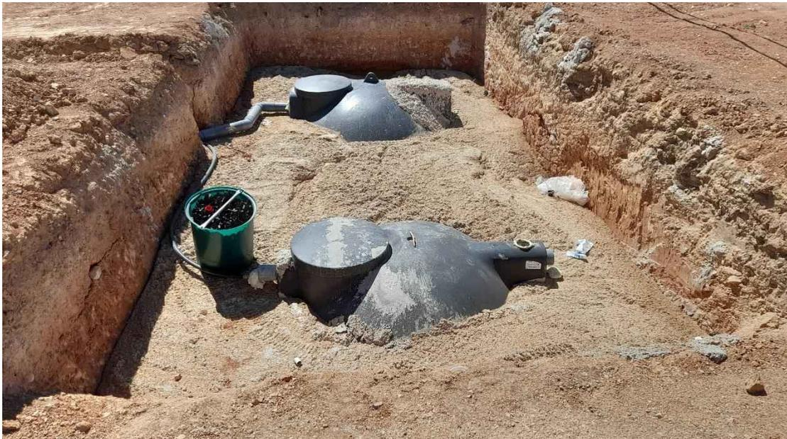
*Foto 20. Progreso de la instalación de fosa séptica y depósito de agua para el edificio de control.*
