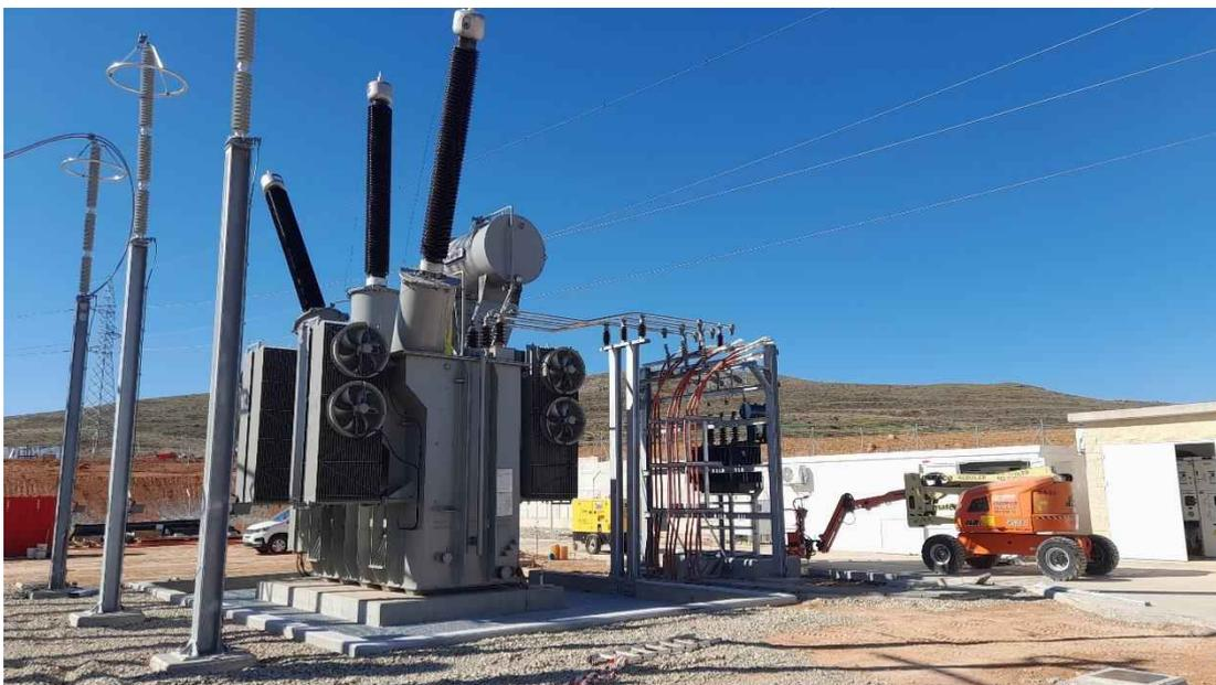
*Foto 29. Trafo instalado en la subestación.*
