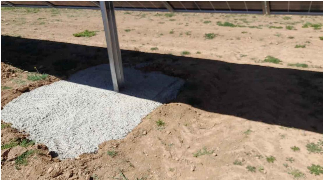
Foto 18. Zapata hormigonada en hinca que no ha penetrado en el terreno en profundidad suficiente. Esta zapata posteriormente será cubierta por tierras para su integración con el resto del terreno (vegetación herbácea).
