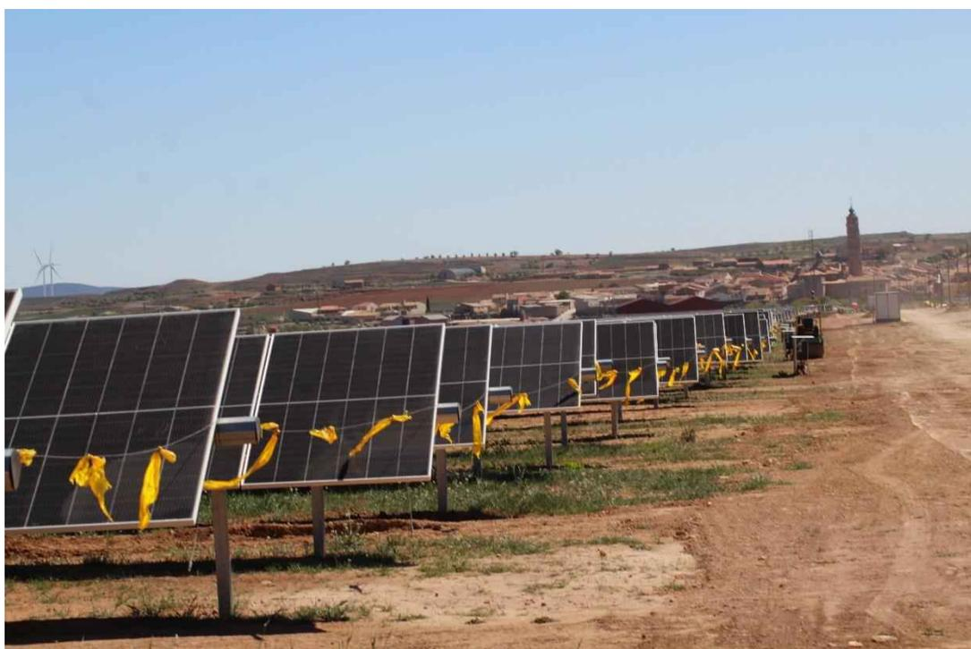
Foto 14. Señalización de seguidores puestos en tensión
