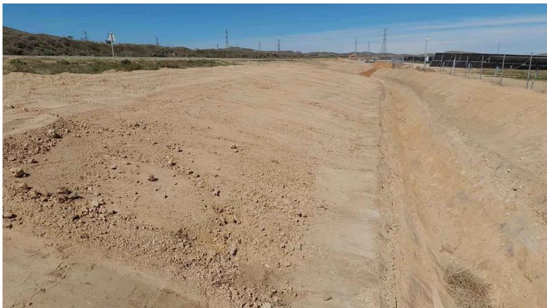
*Foto 16. Adecuación del terreno junto a la obra de drenaje. Las tierras excedentes se llevan a áreas de la planta con puntos bajos, mejorando al red de drenaje.*
