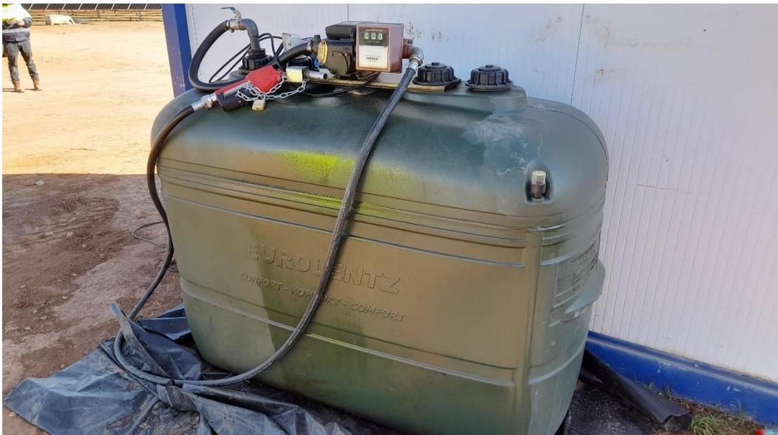
*Foto 6. Depósito de gasoil en la zona de oficinas e instalaciones auxiliares.*
