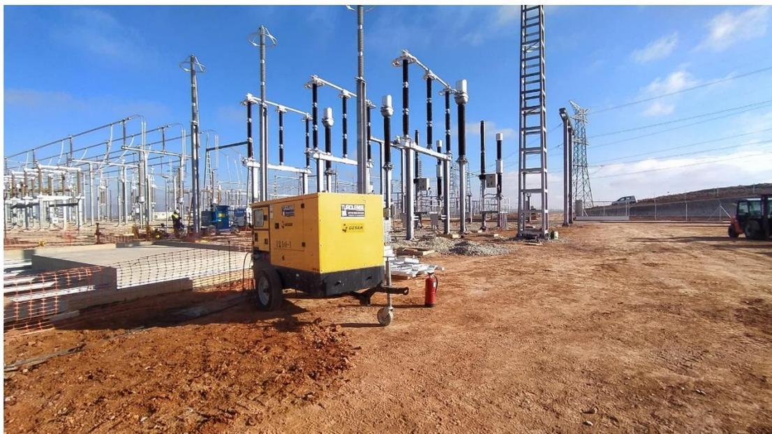
Foto 21. Grupo electrógeno y avance del montaje de embarrados.
