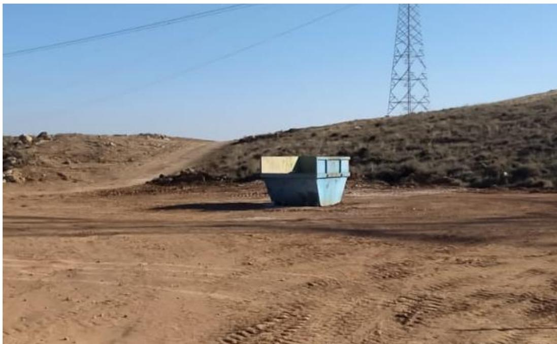
Foto 19. Contenedor para el lavado de canaletas de cubas hormigoneras y restos de hormigón fresco.
