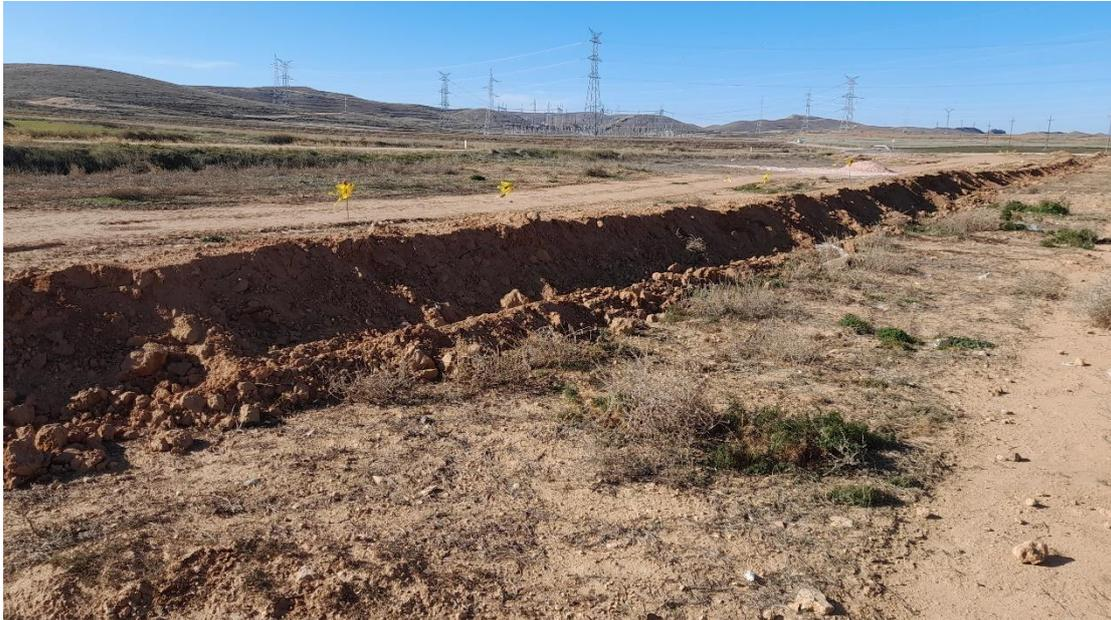
*Foto 15. Cuneta y Jarillón para drenaje de protección de la planta.*
