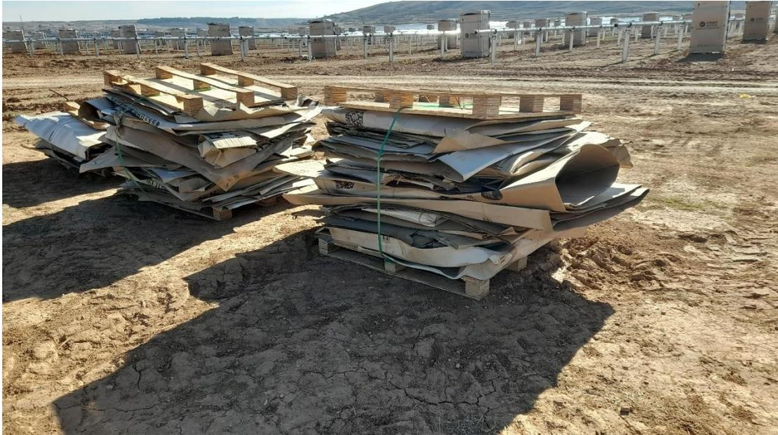
*Foto 3. Zona de residuos de construcción y demolición (RCD). Acopio de papel y cartón.*
