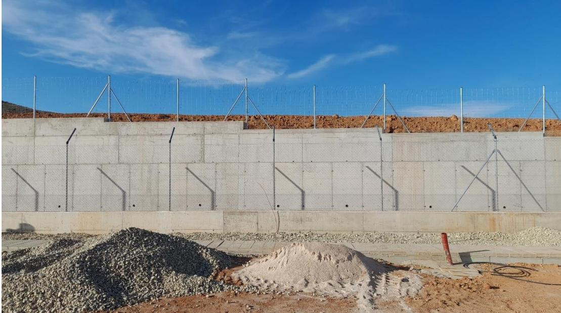
*Foto 22. Muro con trasdós. Apreciación de los vallados cinagético y perimetral definitivos.*
