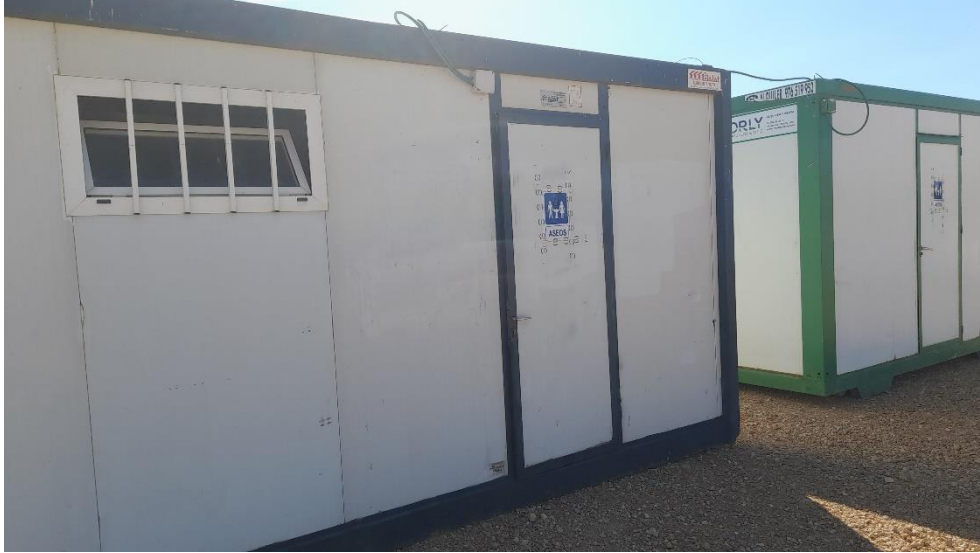
Foto 11. Aseos y vestuarios fijos de nueva instalación en campamento de obra.
