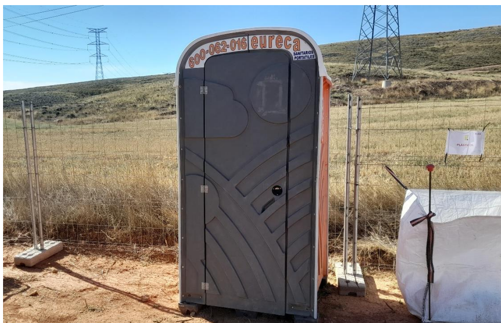
Foto 29. Baños químicos en campamento de obra
