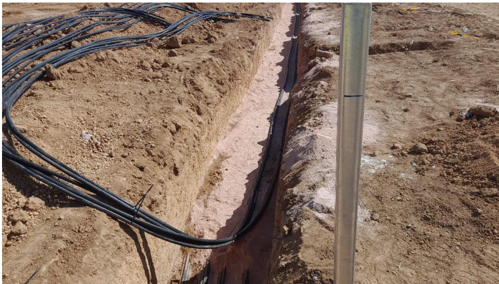
Foto 20. Zanja con cama de arena y tendido de cable.
