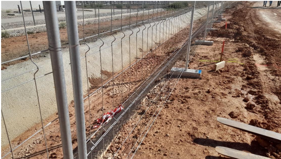
Foto 23. Vallado en zona de obras
