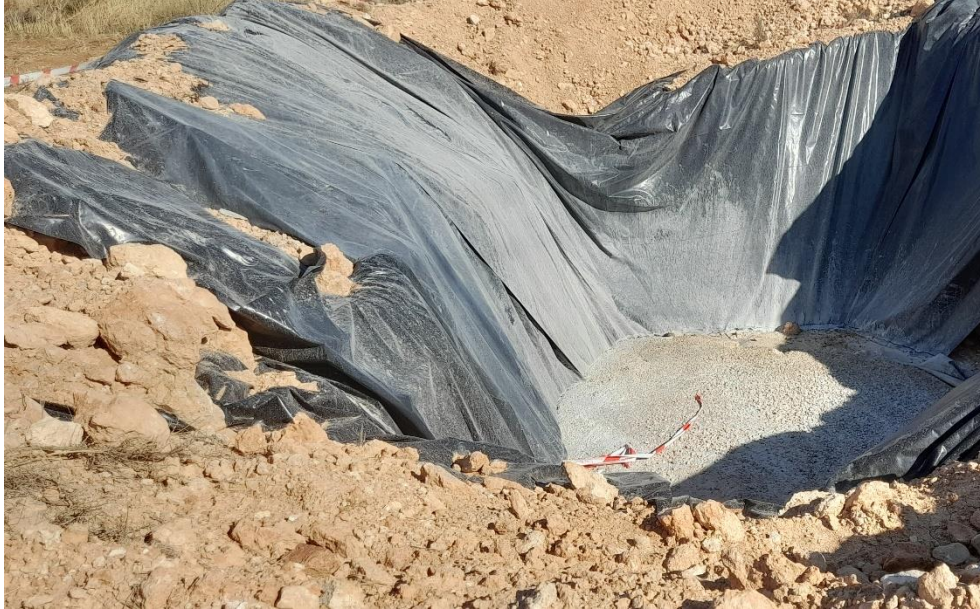
Foto 34. Zona de limpieza de camiones hormigonera
