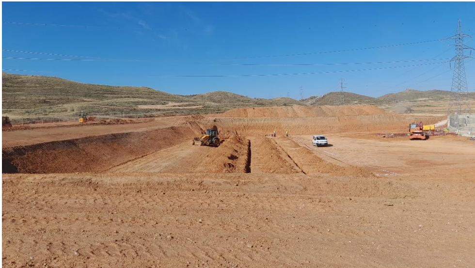
Foto 30. Vista general de los trabajos
