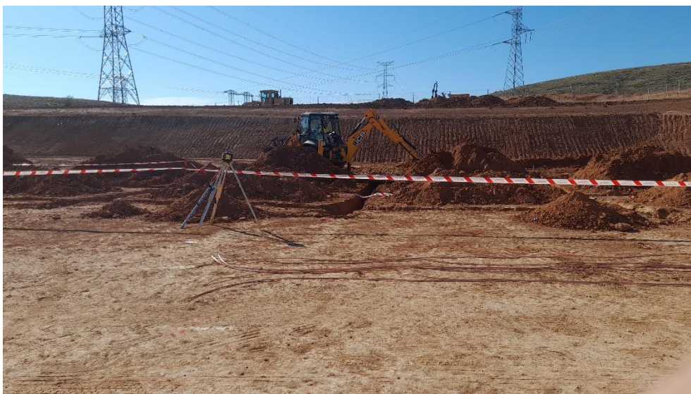
Foto 31. Excavación de zanjas para cables
