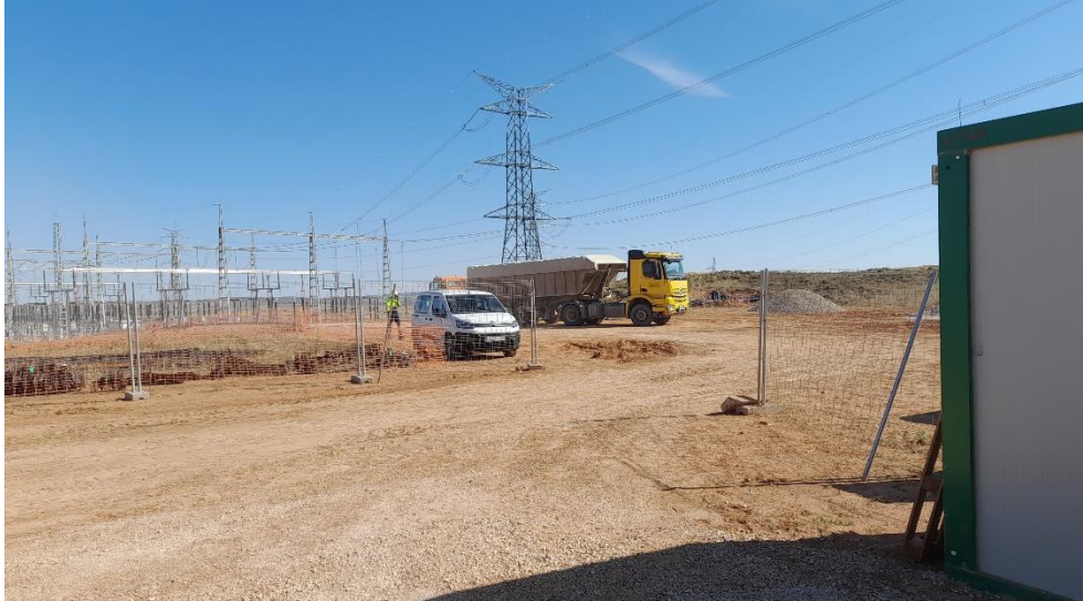
Foto 22. Vallado y acceso a campamento de obra
