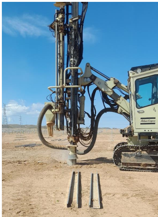
Foto 17. Trabajos con perforadora para hincado de soportes de seguidores en zonas de roca
