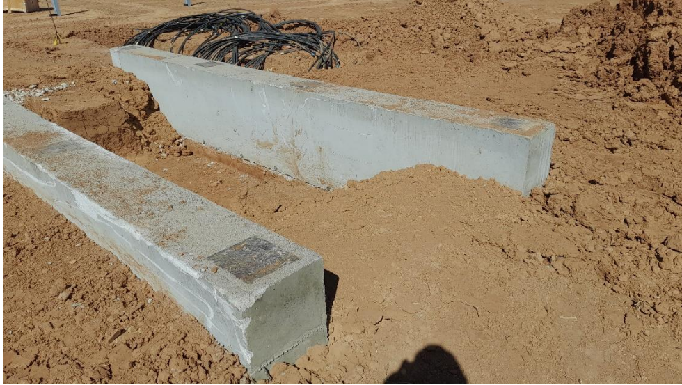
Foto 19. Hormigonado de cimentaciones de CTs
