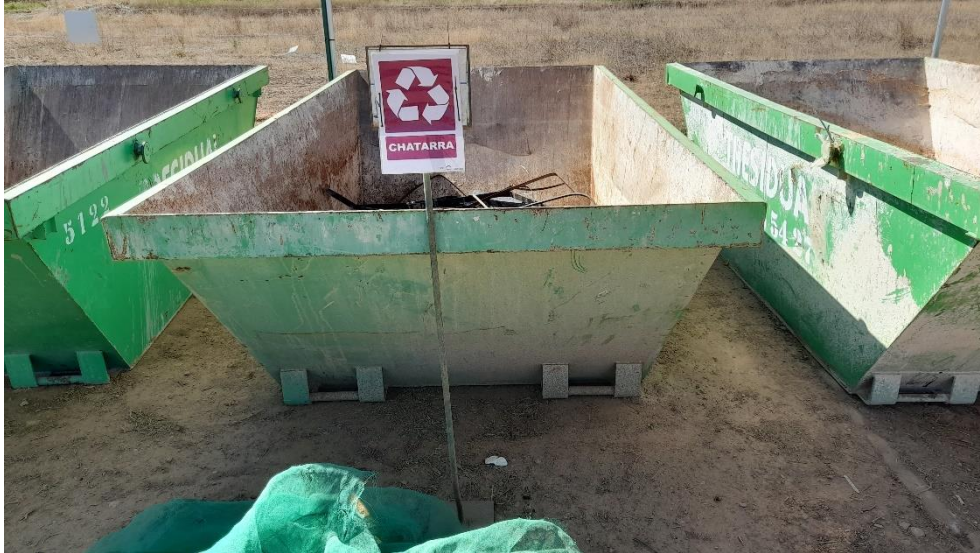
Foto 1. Zona de residuos de construcción y demolición (RCD). Contenedor de chatarra
