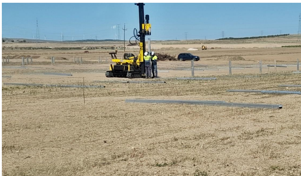
Foto 16. Hincado de soportes de seguidores
