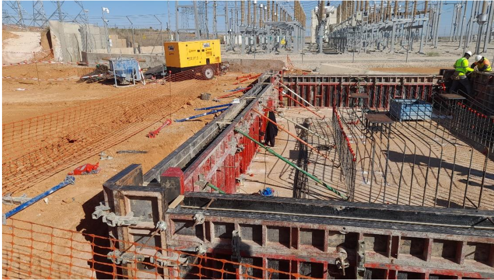
Foto 32. Encofrado para hormigonado de cimentaciones
