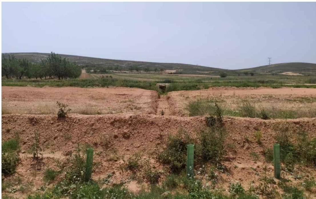
Foto 9. Aspecto de la obra de drenaje: jarillón de protección y banda de plantaciones.
