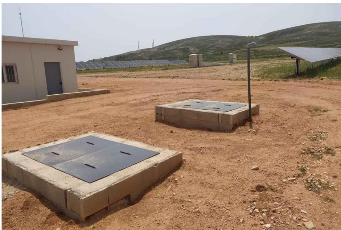
Foto 6. Arquetas de fosa séptica y depósito de agua.
