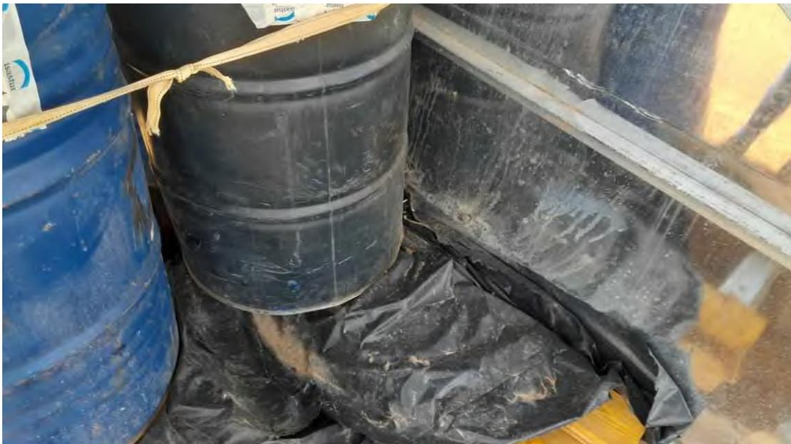
Foto 14. Contenedores para almacenamiento de residuos peligrosos. Superficie impermeabilizada.
