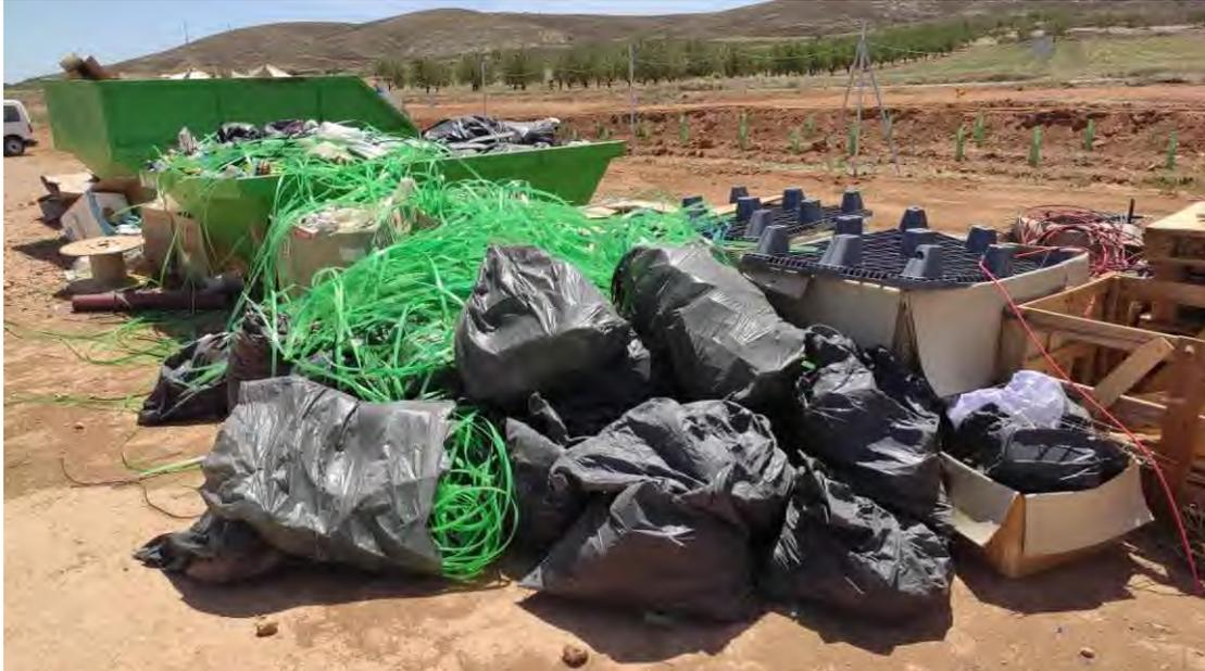
*Foto 1. Gestión de RCDs: Contenedores con RCds de distintas tipologías y bolsas con flejes de plástico acopiadas para su retirada.*
