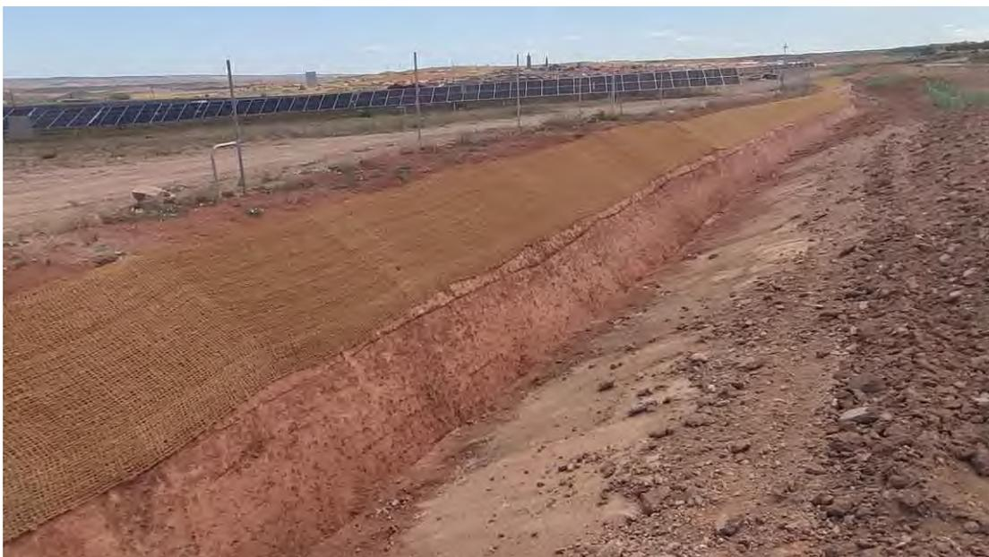
*Foto 8. Aspecto de las labores de revegetación: manta orgánica en jarillón de protección de drenaje y banda de plantaciones.*
