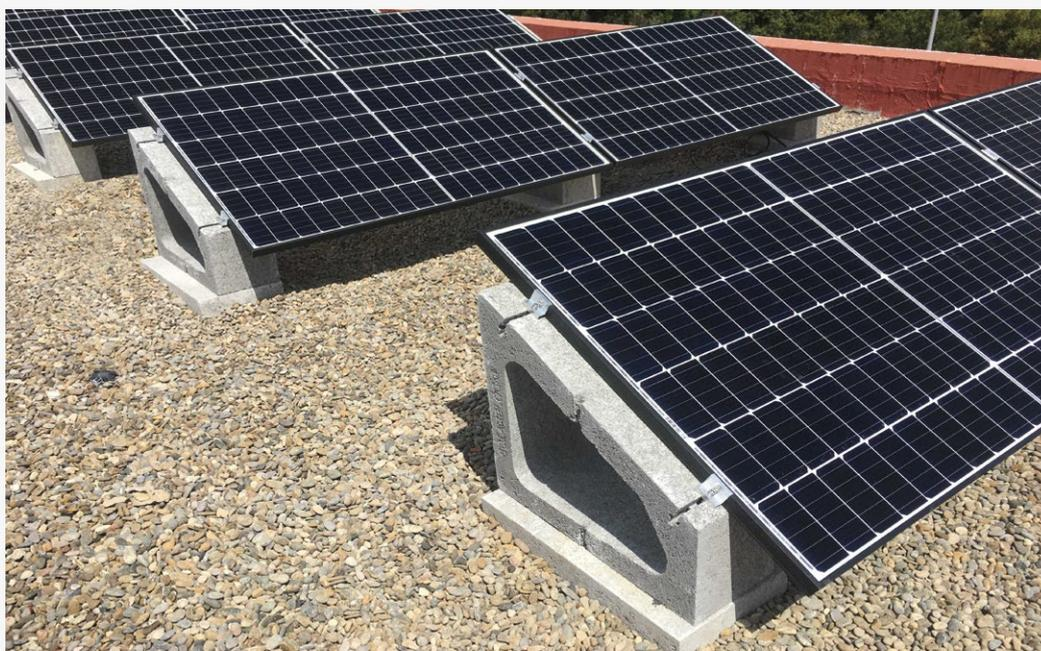
El sistema Solarbloc® permite fijar los módulos solares directamente al soporte sin utilizar estructura metálica. **Los soportes Solarbloc® se fabrican en ocho grados distintos, 3°, 10°, 12°, 15°, 18°, 28°, 30° y 34°.** Debemos elegir la inclinación del soporte más idónea teniendo en cuenta las necesidades de la instalación.
