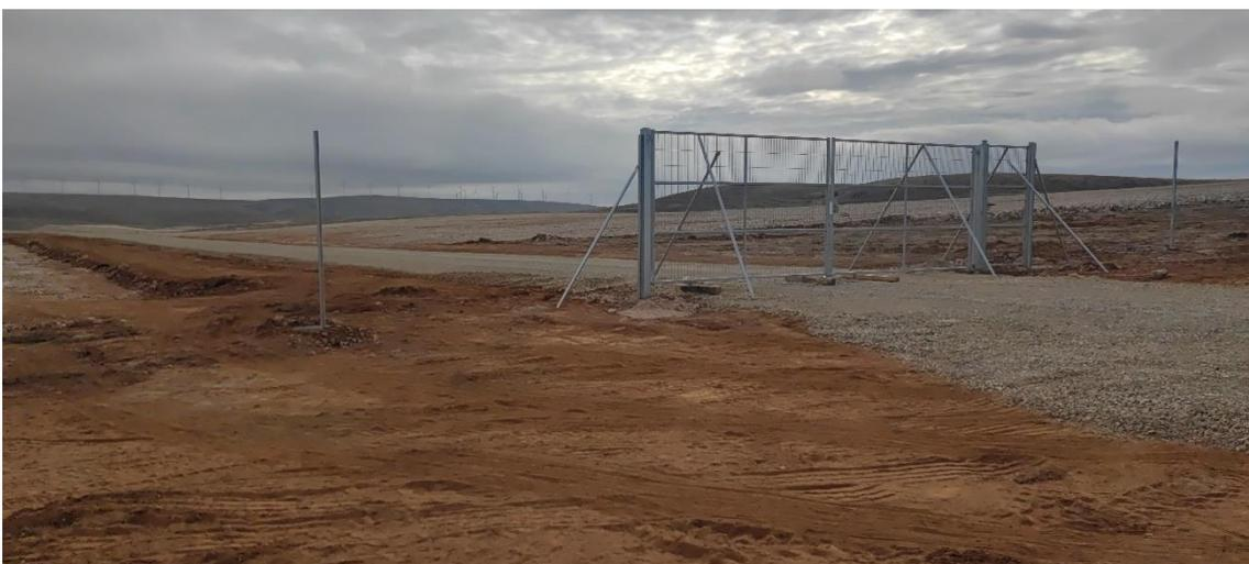
*Ilustración 3. Correcta instalación de las puertas de acceso en los vallado aprovechando la red de viales existentes.*
