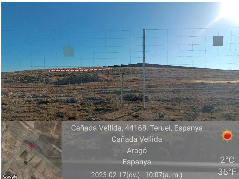
*Ilustración 7. Pasos de fauna (sin excavar) y placas anticolidión en vallados*
