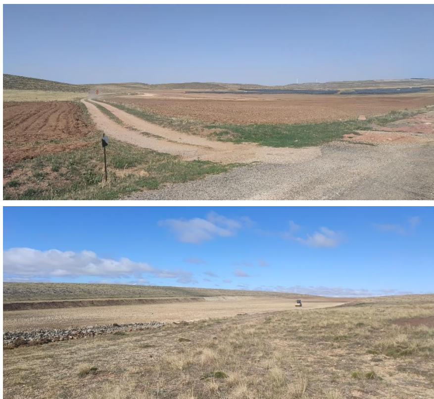
Ilustración 8. Movimientos de tierra, apertura de viales y desbroces en las poligonales 3 (arriba) y 5 (abajo) en las visitas 4 y 5.
