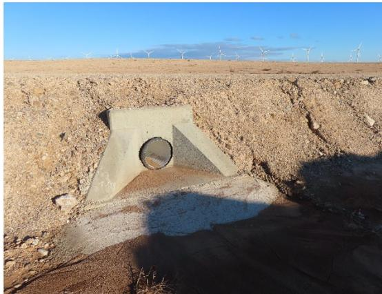
ODT concluida con plataforma de disipación de energía a la salida.
