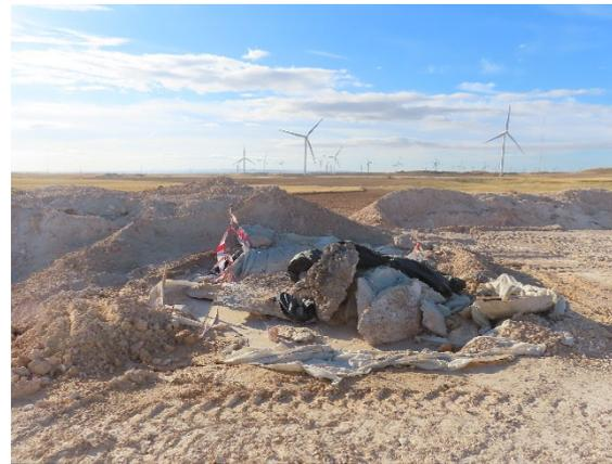
Pozo de lavado de hormigoneras desmantelado, previamente a su retirada y entrega a gestor autorizado.
