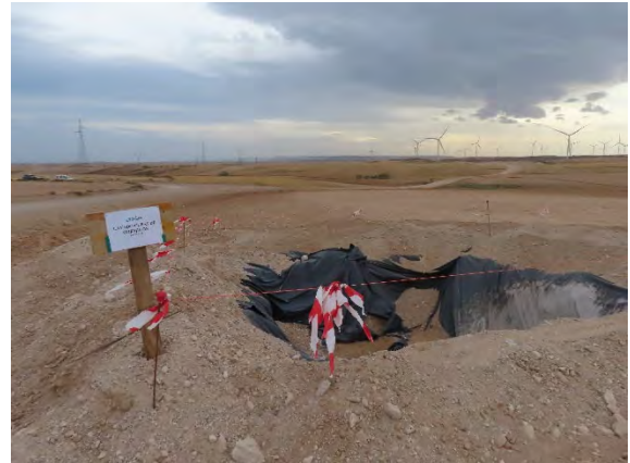
Nuevo pozo de lavado habilitado por Cobra junto a la obra de la SET.
