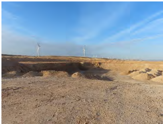
Zona de préstamo donde se están depositando tierras procedentes de la obra.
