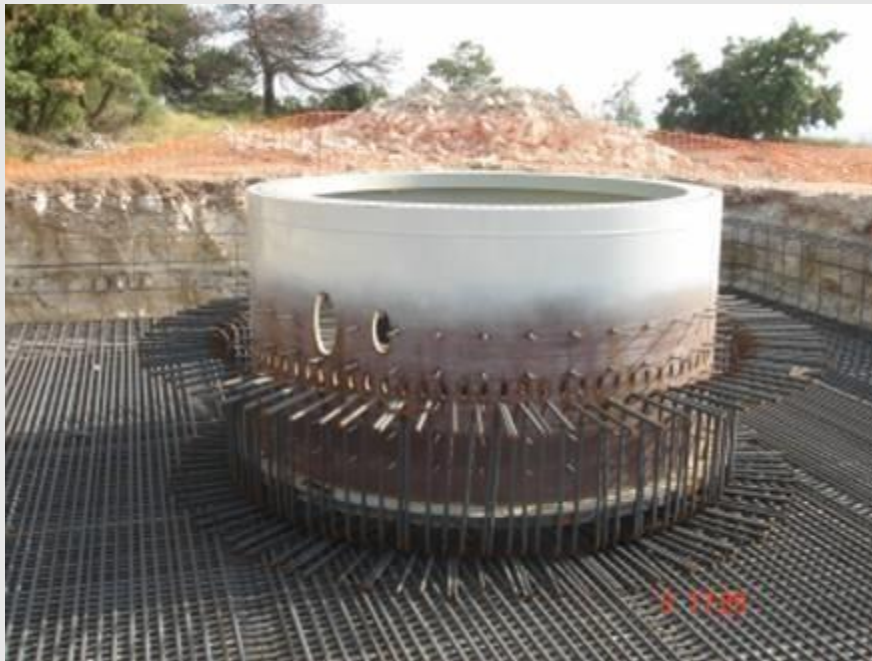
6 Armadura de una zapata y virola de anclaje
