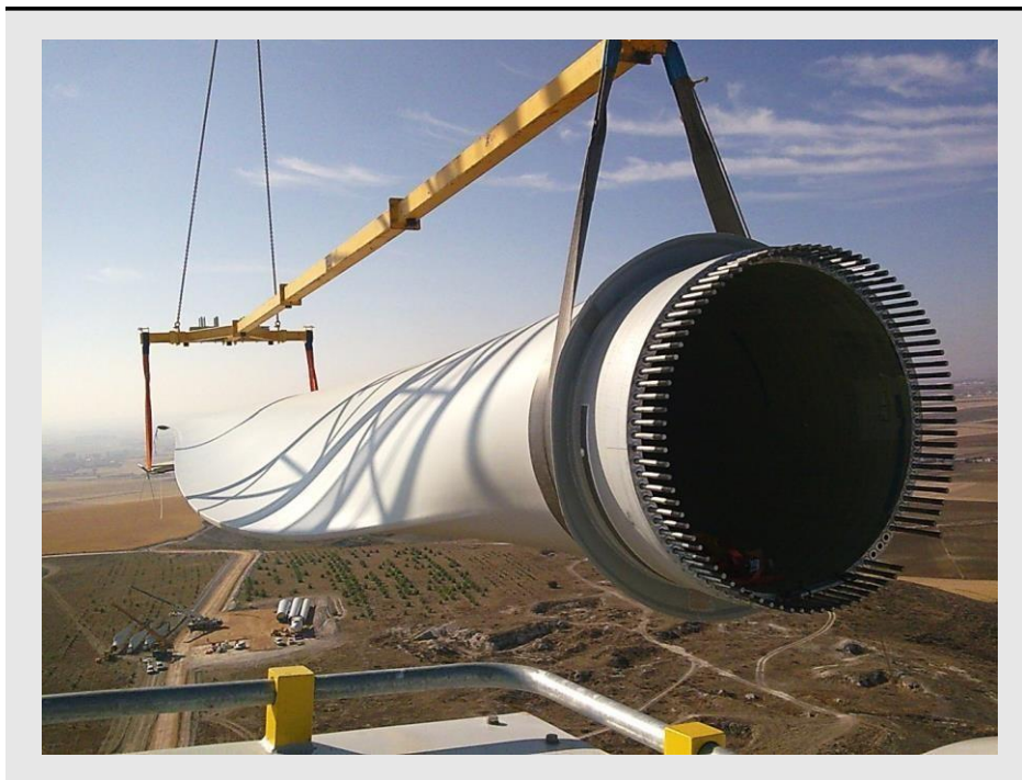
3 Desmontaje de una pala
