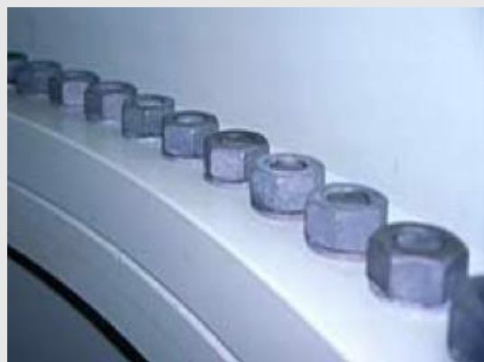
Pernos de unión de las secciones de una torre
