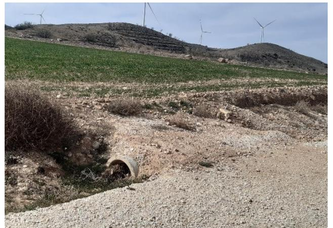
Fig. 6 Tubo de drenaje semitaponado con vegetación arbustiva y sedimentos en vial de acceso al aero LM6D.04. Fuente: Elaboración propia
