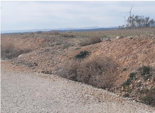
Fig. 5 Tubo de drenaje taponado por vegetación arbustiva en vial de acceso al aero LM6D.02. Fuente: Elaboración propia
