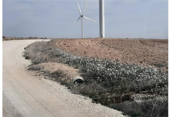
Fig. 4 Tubo de drenaje taponado por vegetación arbustiva en vial de acceso al aero LM6C.06. Fuente: Elaboración propia
