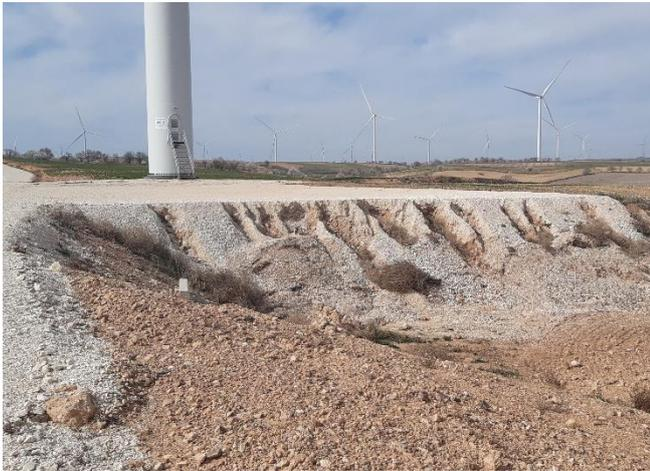
Fig. 3 Erosión hídrica en materiales lutíticos del talud terraplén de plataforma del aero LM6C.07. Fuente: Elaboración propia
