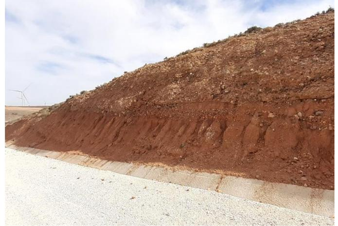
Fig. 2 Erosión hídrica en materiales lutíticos del talud de desmonte del vial de acceso al aero LM6C.12. Fuente: Elaboración propia
