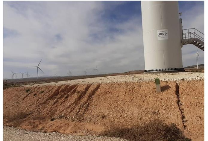
Fig. 4 Erosión hídrica en cimentación del aero LM6C.04. Fuente: Elaboración propia
