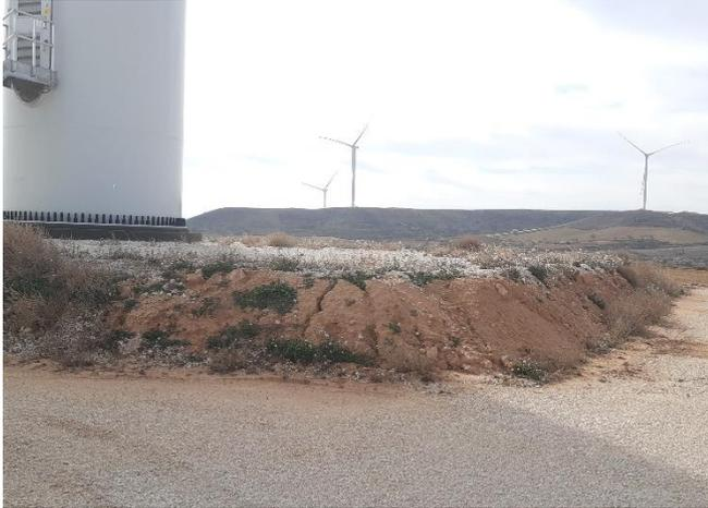
Fig. 1 Erosión hídrica en materiales lutíticos del talud de desmonte del vial de acceso al aero LM6B.10. Fuente: Elaboración propia
