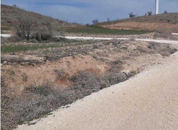
Fig. 3 Tubo de drenaje semitaponado con vegetación arbustiva en vial de acceso al aero LM6C.12. Fuente: Elaboración propia
