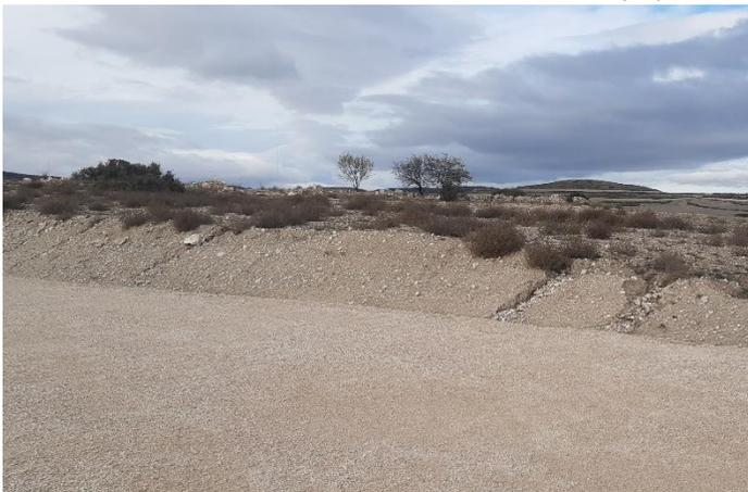
Fig. 3 Erosión hídrica en materiales margosos del talud de desmonte de plataforma del aero L6A.04. Fuente: Elaboración propia
