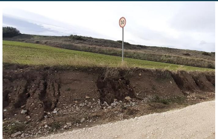
Fig. 2 Erosión hídrica en materiales lutíticos del talud de desmonte del vial de acceso al aero L6A.06. Fuente: Elaboración propia
