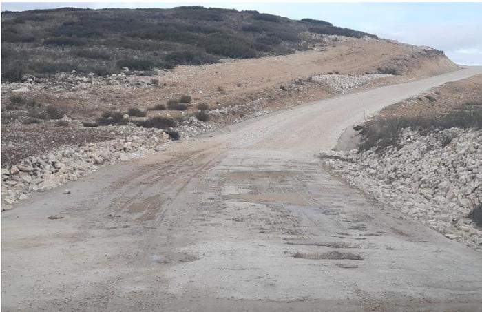
Fig. 3 Encharcamiento en vado en vial de acceso al aero L6A.07. Fuente: Elaboración propia
