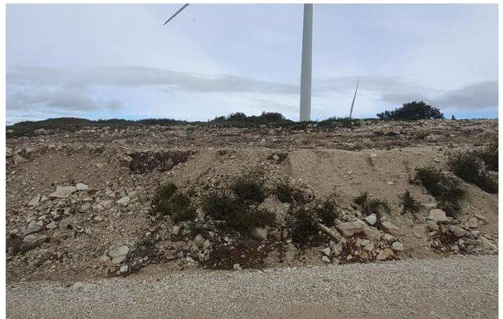
Fig. 6 Erosión hídrica en materiales margo-arenosos del talud de desmonte del vial de acceso al aero L6A.09. Fuente: Elaboración propia
