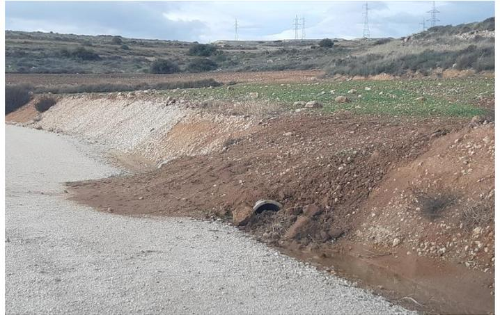
Fig. 2 Tubo de drenaje taponado por sedimentos en vial de acceso al aero L6A.13. Fuente: Elaboración propia
