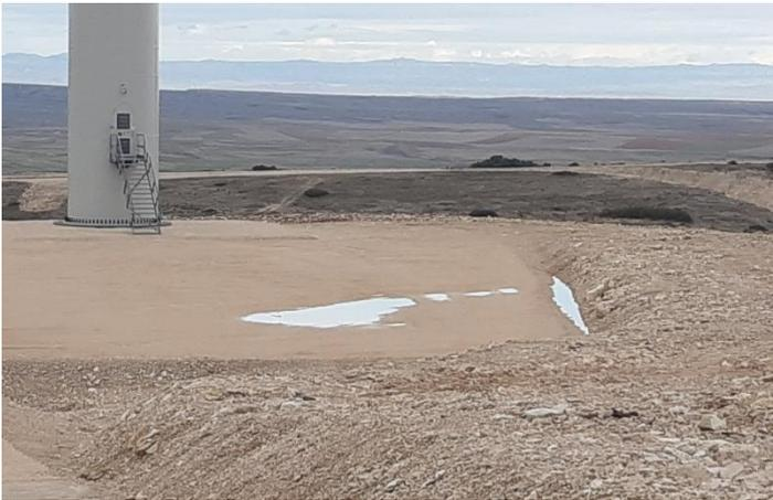
Fig. 1 Encharcamientos en plataforma del aero L6A.10. Fuente: Elaboración propia
