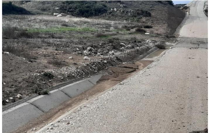
Fig. 4 Cuneta encharcada y con sedimentos en vial de acceso al aero L6A.06. Fuente: Elaboración propia
