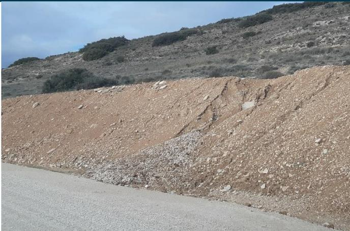
Fig. 1 Erosión hídrica en materiales lutíticos del talud de desmonte del vial de acceso al aero L6A.07. Fuente: Elaboración propia
