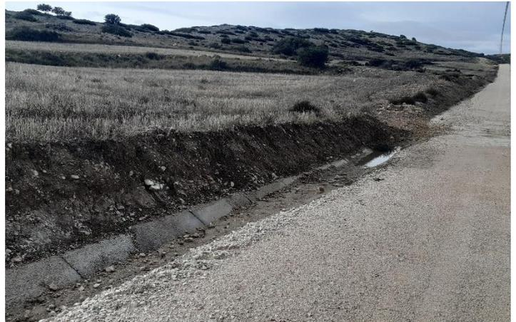
Fig. 4 Cuneta encharcada y con sedimentos en vial de acceso al aero L6A.03. Fuente: Elaboración propia
