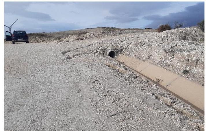
Fig. 4 Erosión hídrica en materiales margosos del vial de acceso al aero L6A.02. Fuente: Elaboración propia
