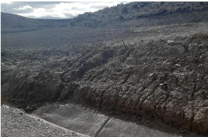
Fig. 5 Erosión hídrica en materiales margosos del talud de desmonte del vial de acceso al aero L6A.05. Fuente: Elaboración propia
