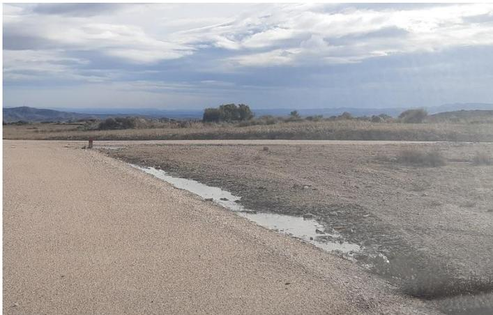
Fig. 3 Encharcamientos en margen dcho. del vial de acceso al aero L6A.05. Fuente: Elaboración propia
