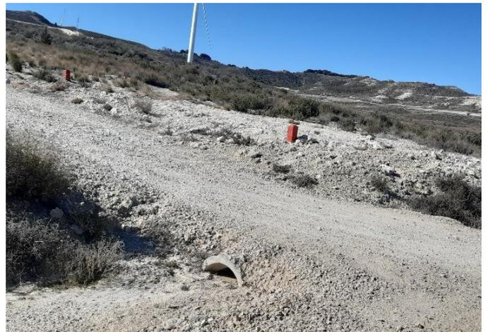
Fig. 4 Tubo de drenaje taponado por sedimentos en vial de acceso al
