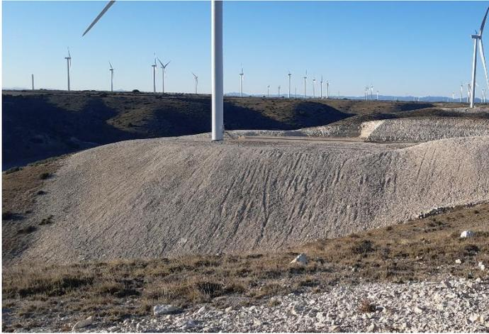
Fig. 1 Revegetación de la plataforma y talud terraplén del aero PO2.1.10 deficiente. Fuente: Elaboración propia
