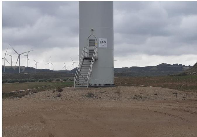
Fig. 3 Entrada del aeró CA.06 precintada. No hay conos de aviso. Fuente: Elaboración propia
