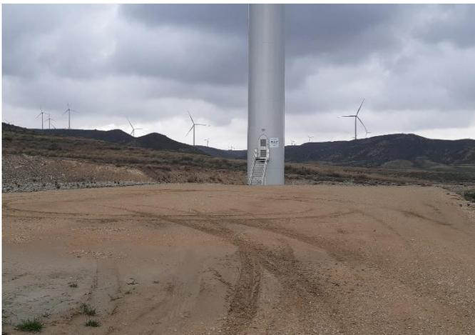
Fig. 3 Rodadas en materiales margo-arenosos de la plataforma del aero
