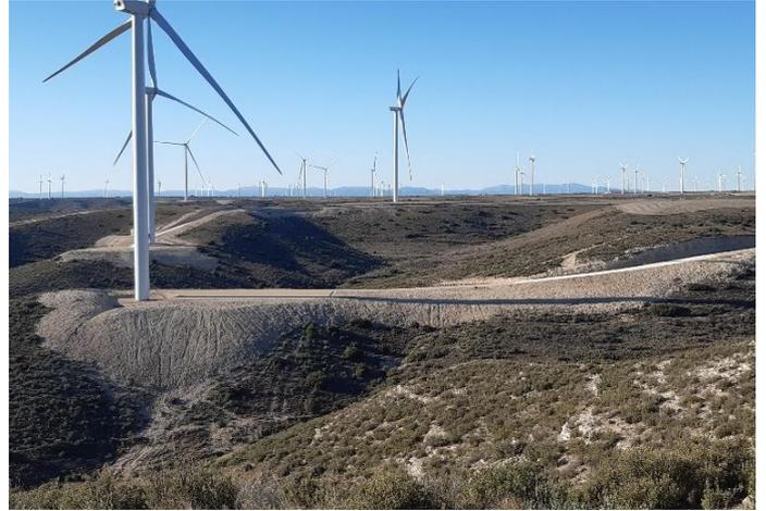
Fig. 4 Revegetación de talud terraplén de plataforma y vial al aero PO2.1.7 deficiente. Fuente: Elaboración propia
