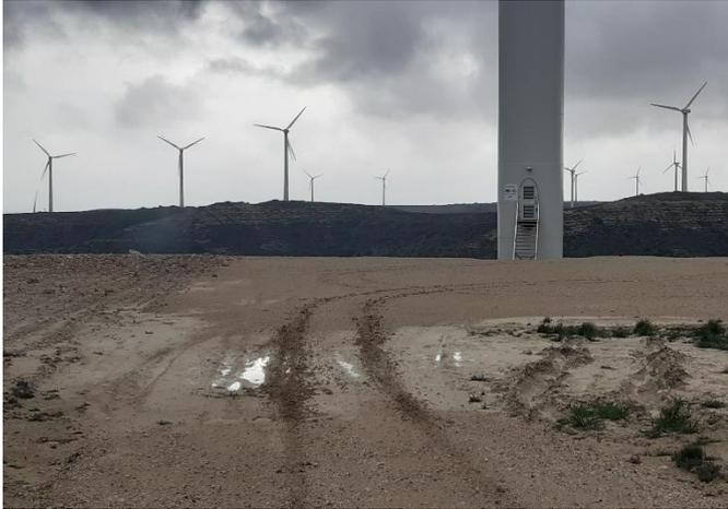
Fig. 1 Rodadas marcadas debido a mal drenaje de plataforma del aero
