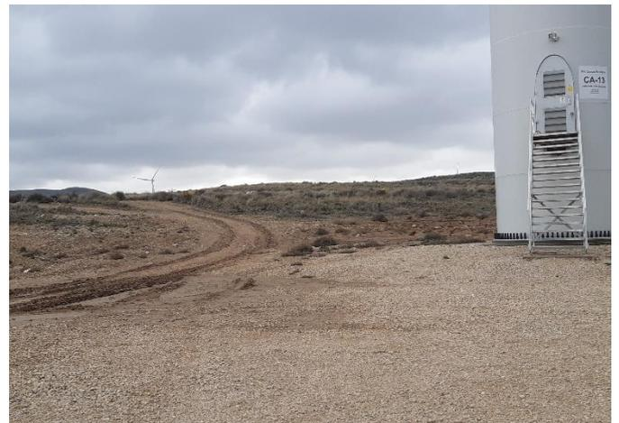
Fig. 4 Rodadas profundas en materiales lutiticos de la plataforma del
