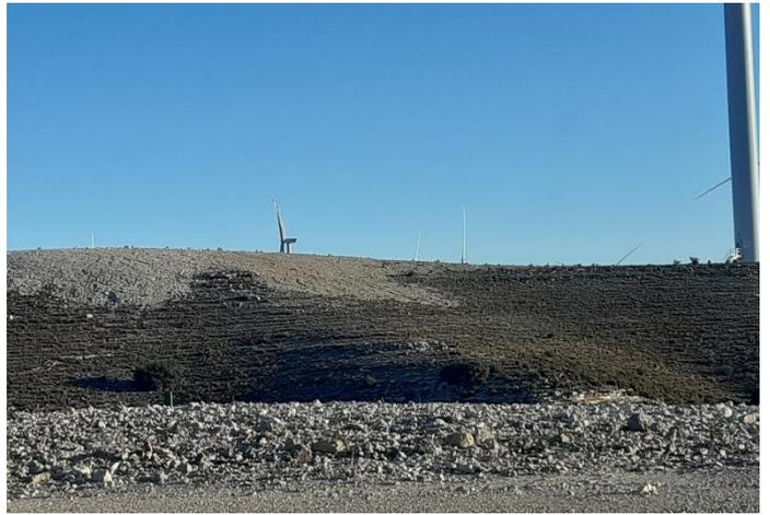
Fig. 2 Revegetación del talud desmonte plataforma del aero PO2.1.11 deficiente. Fuente: Elaboración propia
