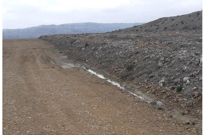
Fig. 2 Encharcamiento en margen de plataforma del aero CA.05.
