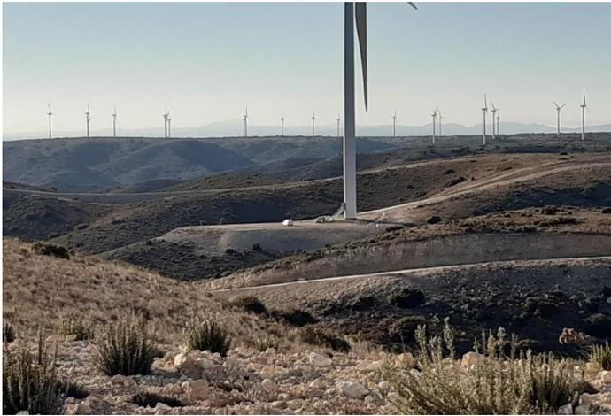
Fig. 3 Revegetación de talud terraplén del aero PO.2.1.6 deficiente. Fuente: Elaboración propia
