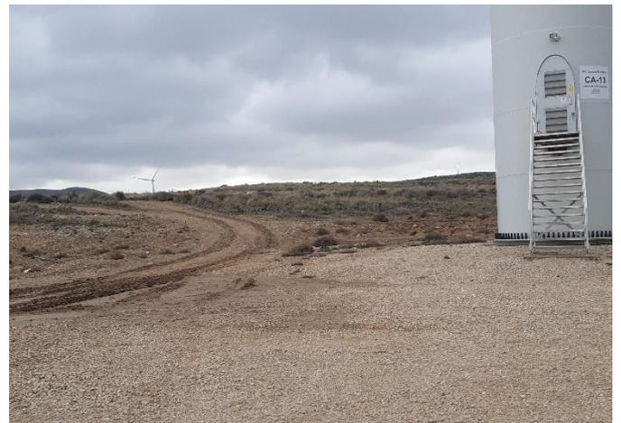
Fig. 4 Rodadas profundas en materiales lutíticos de la plataforma del
