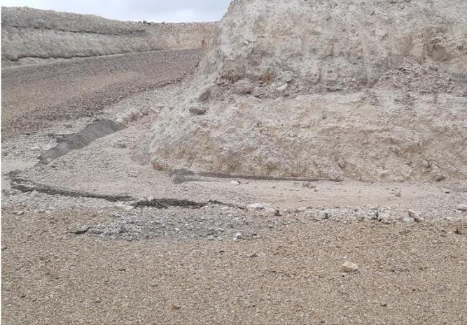
Fig. 1 Cuneta llena de sedimentos en plataforma del aero PO2.2.4.
