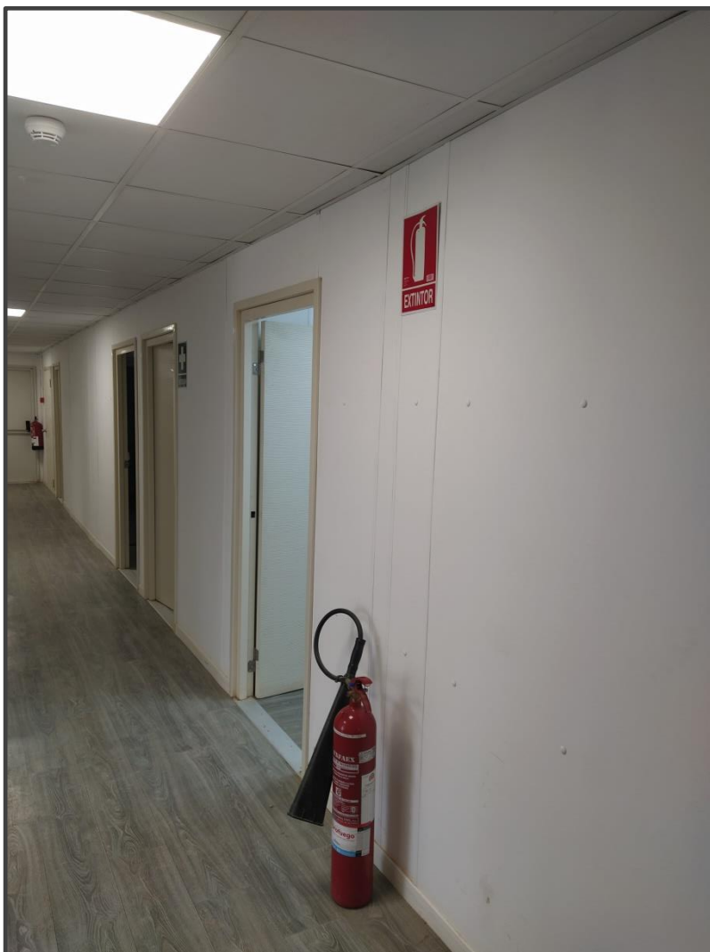
Fotografía 7. Extintores en edificio de control.
