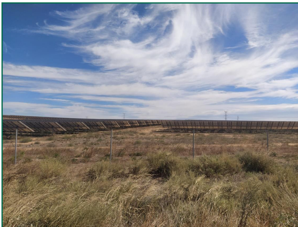
Fotografía 1. Vegetación entre placas actualmente.
