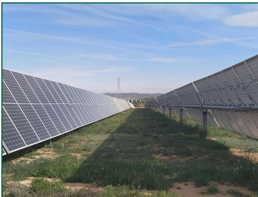
Fotografías 1. Vegetación entre placas actualmente.
